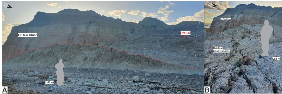
Figura 55. Deslizamiento RM-D2. A) Grietas transversales. B) Sección transversal del lóbulo erosionado.
