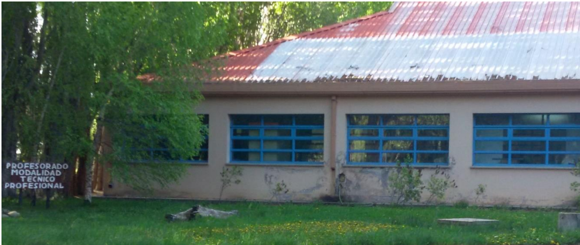
Foto 27 Parte del edificio de talleres de la Escuela Agropecuaria Provincial N°1.
