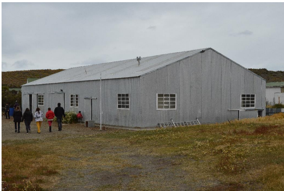
Foto 13 Galpón de esquila, espacio acondicionado para la Escuela Primaria Provincial Rural N° 92 Maestros de la Patagonia.
