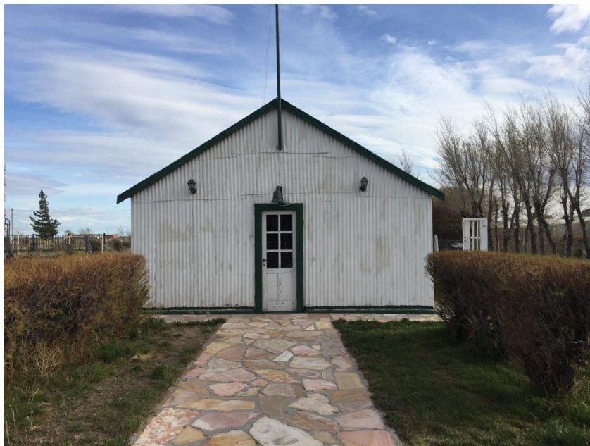
Foto 28 Edificio antiguo de la Escuela Primaria Provincial N° 20 Malvinas Argentinas.
