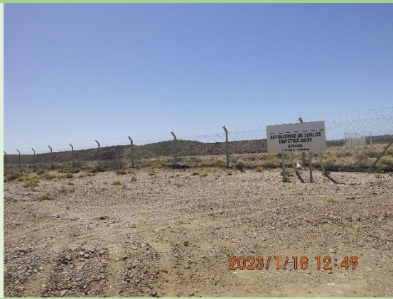
Figura 29-Cartería y cercado perimetral
