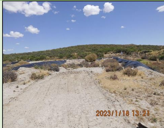
Figura 36-Box con vista de geomembrana
