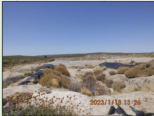
Figura 38-Box con geomembrana y revegetación
