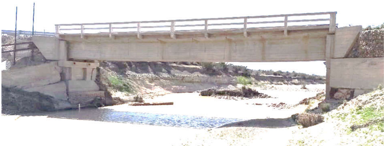
Imagen 27. Fotografía del puente. Vista desde aguas arriba (aporte: AVP)
