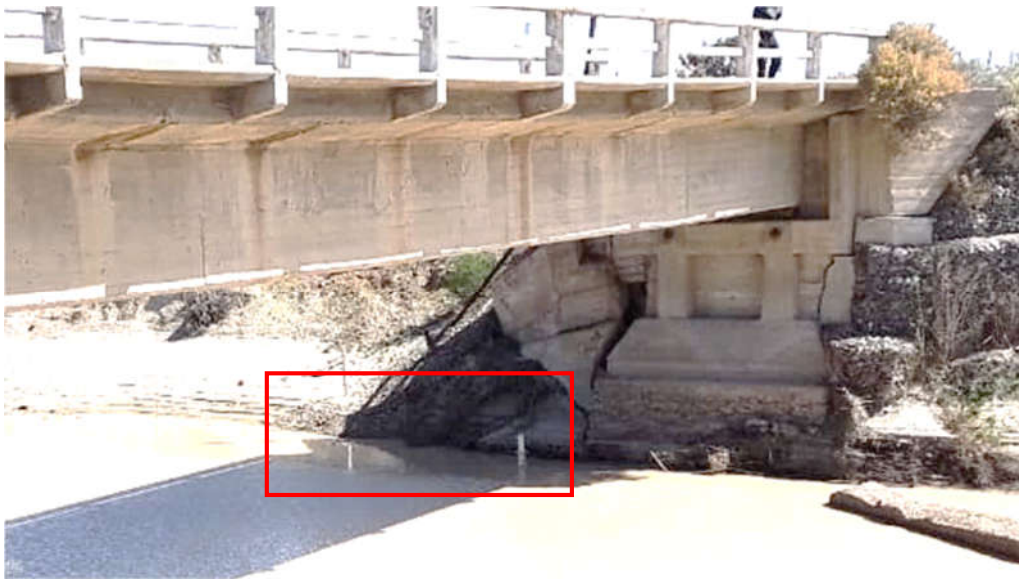
Imagen 35. Fotografía del puente desde aguas abajo. Se observan las escalas ubicadas en el lugar. (aporte: AVP)
