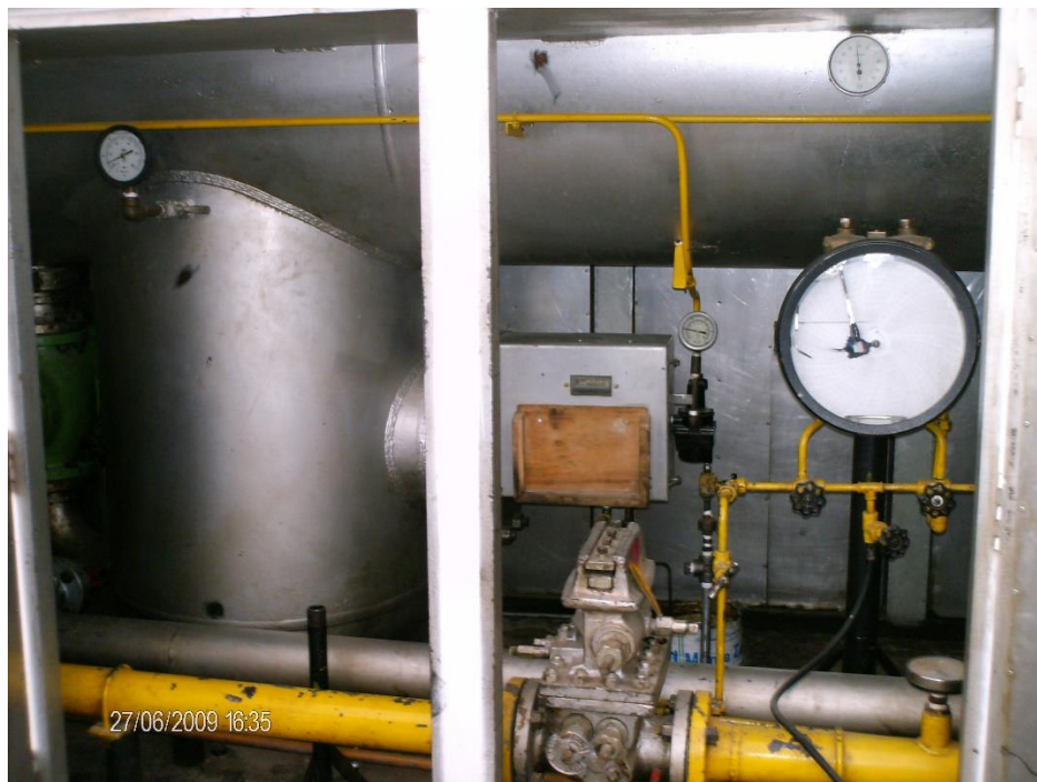
Imagen: separador bifásico de control de la batería Granson.
