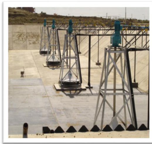
Figura 7b. Pileta de aireación con Hiperboloides.
