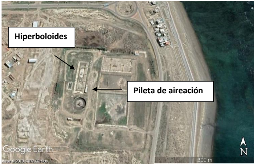
Figura 4. Vista aérea de la planta de tratamiento.
