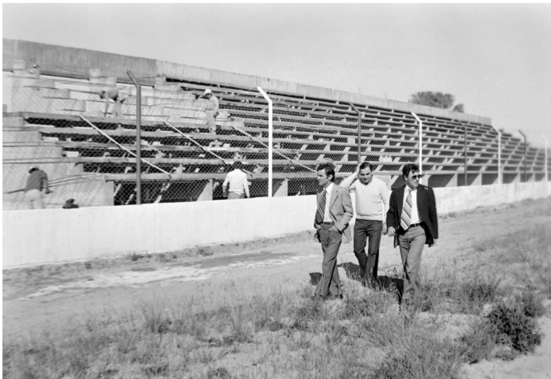
1979 Cayetano Castro, Carlos Oca y Cesar Mac Karthy verifican la construcción de la tribuna principal
