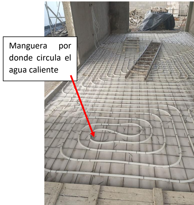
Figura 26: Canalización losa radiante (estar comedor)
