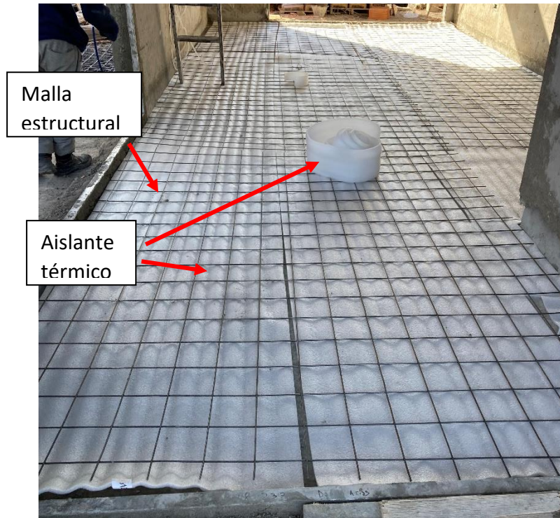
Figura 24: Aislación y malla losa planta baja (estar comedor)
