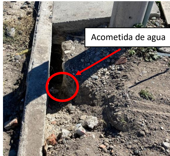
Figura 13: Acometida de agua
