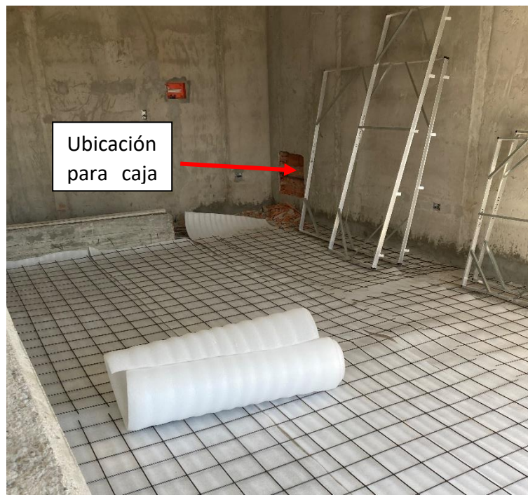
Figura 25: Aislación y malla losa planta alta (estudio)
