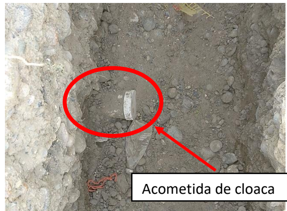
Figura 14: Acometida de cloaca
