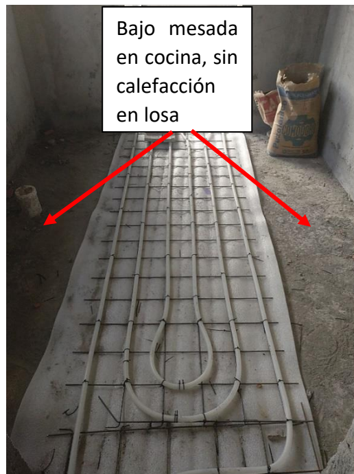
Figura 27: Canalización losa radiante cocina
