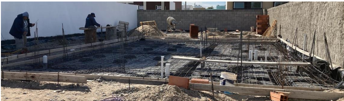
Figura 16: Armado de platea 02
