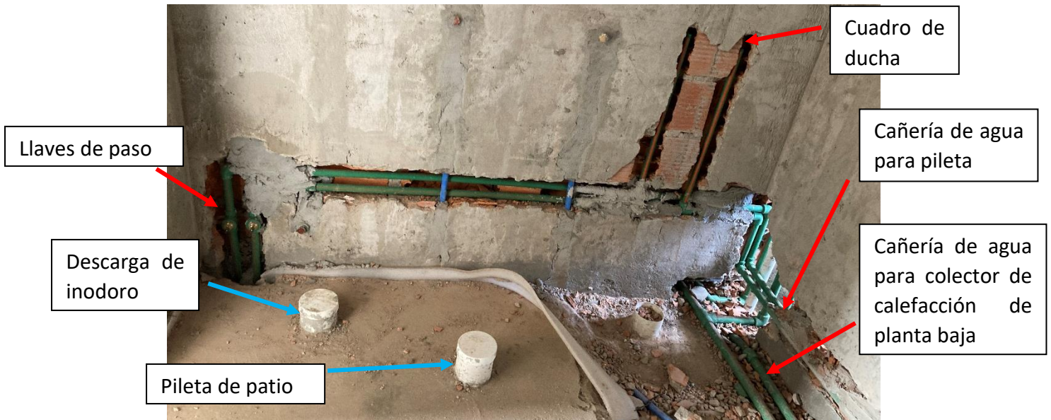
Figura 33: Distribución de agua en baño
