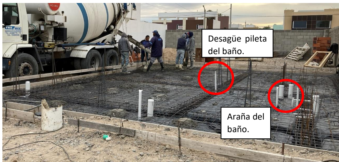
Figura 17: Hormigonado de platea
