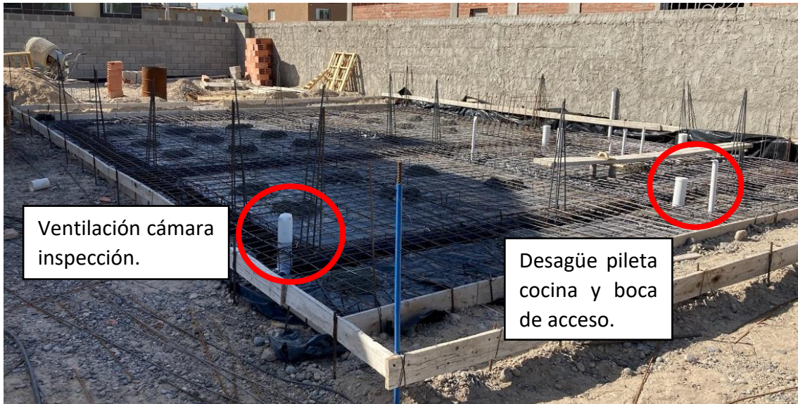
Figura 15: Armado de platea 01
