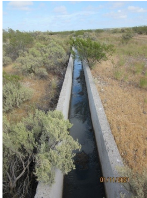
Fig.9: Canal cementado que comunica el centro de bombeo del PIT con cada laguna.
