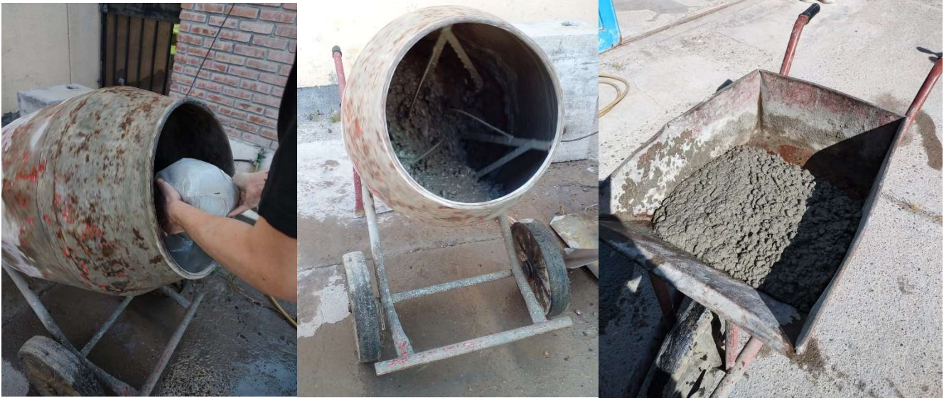
Figura 9 Proceso de fabricación del H° a/c: 0,55 (Áridos sin Corregir)
