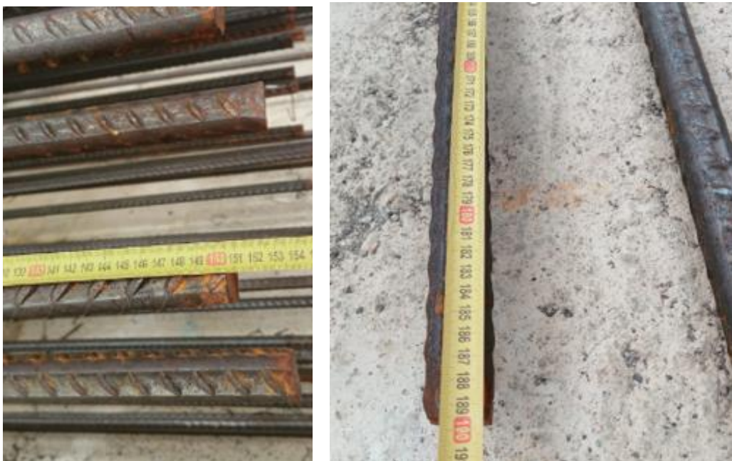
Imagen 4. Control de longitudes de empalme de los diversos tramos de armadura de pilote.
