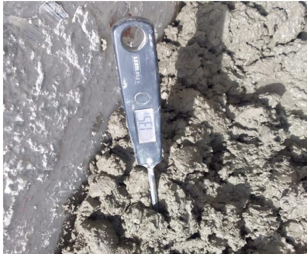
Imagen 7. Medición de la temperatura del hormigón salido de planta.
