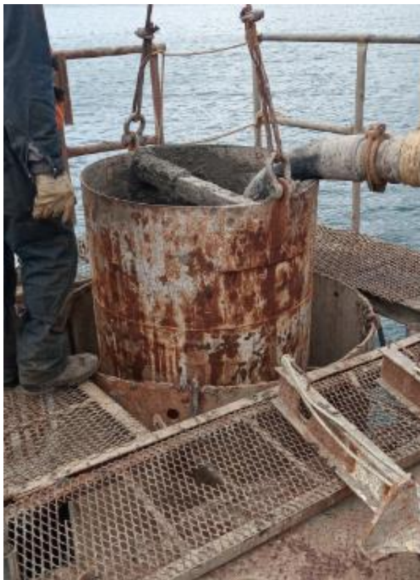
Descarga de hormigón en embudo conectado con tubería tremie.
