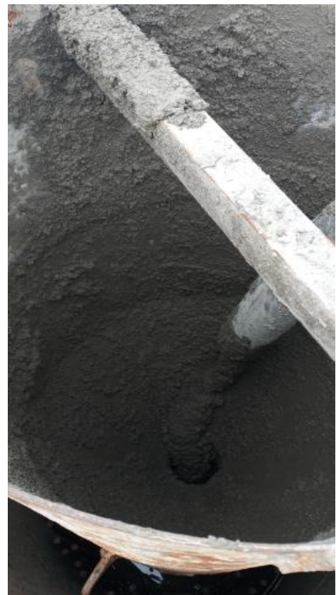
Descarga de hormigón en embudo conectado con tubería tremie.
