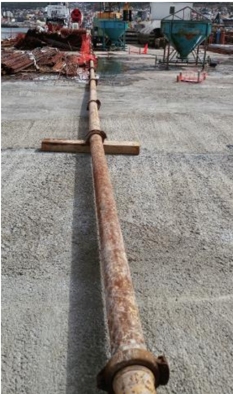
Recorrido de hormigón en tubería bomba arrastre de \phi 5 ".
