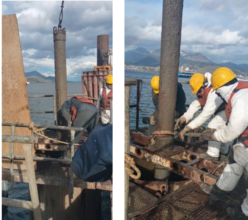
Extracción de tubería tremie con el avance de hormigonado.
