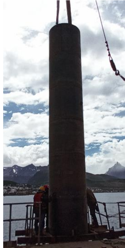
Secuencia de montaje de camisa de pilote.
