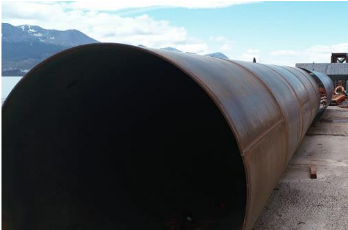
Acopio de camisas metálicas y armaduras de pilote.
