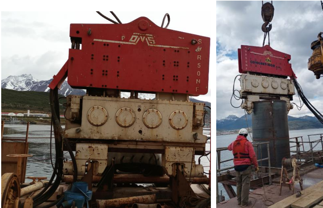
Vibrohincador e hincado de un tramo de camisa.
