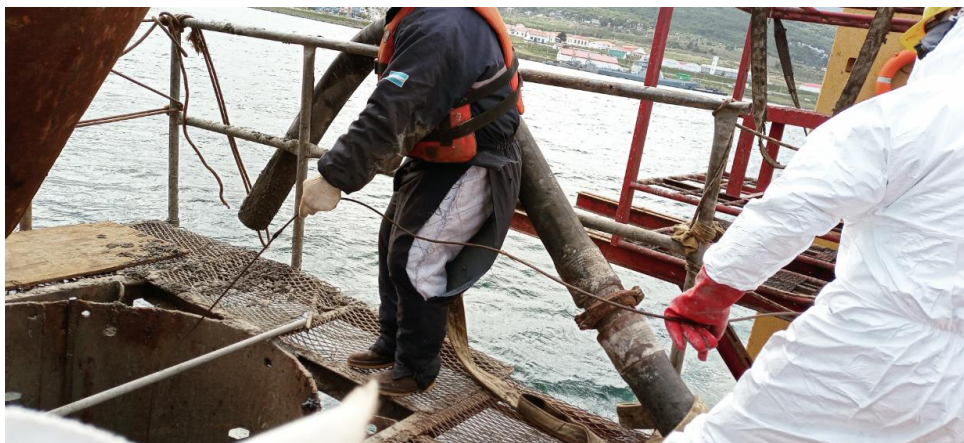
Sondeo en pilote para conocer profundidad de hormigonado.
