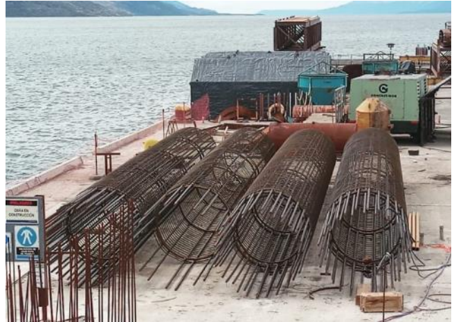
Acopio de camisas metálicas y armaduras de pilote.
