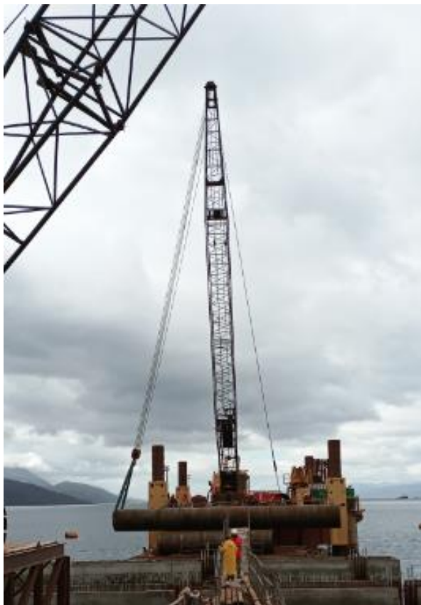
Secuencia de montaje de camisa de pilote.
