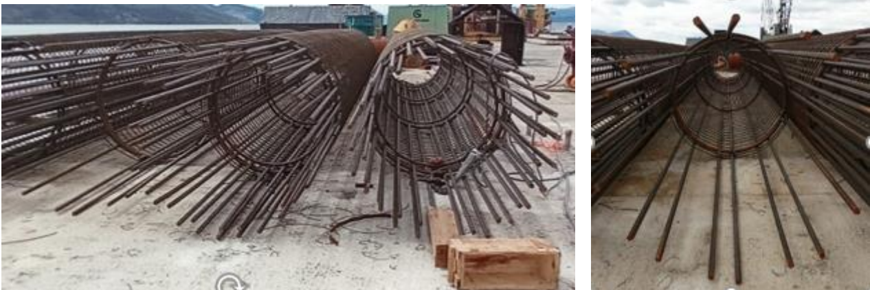
Imagen 3. Control de distribución y cuantía de armadura de pilote según cada tramo.
