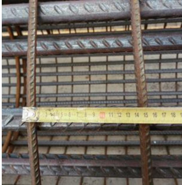
Imagen 5. Control de diámetro y separación de espirales.
