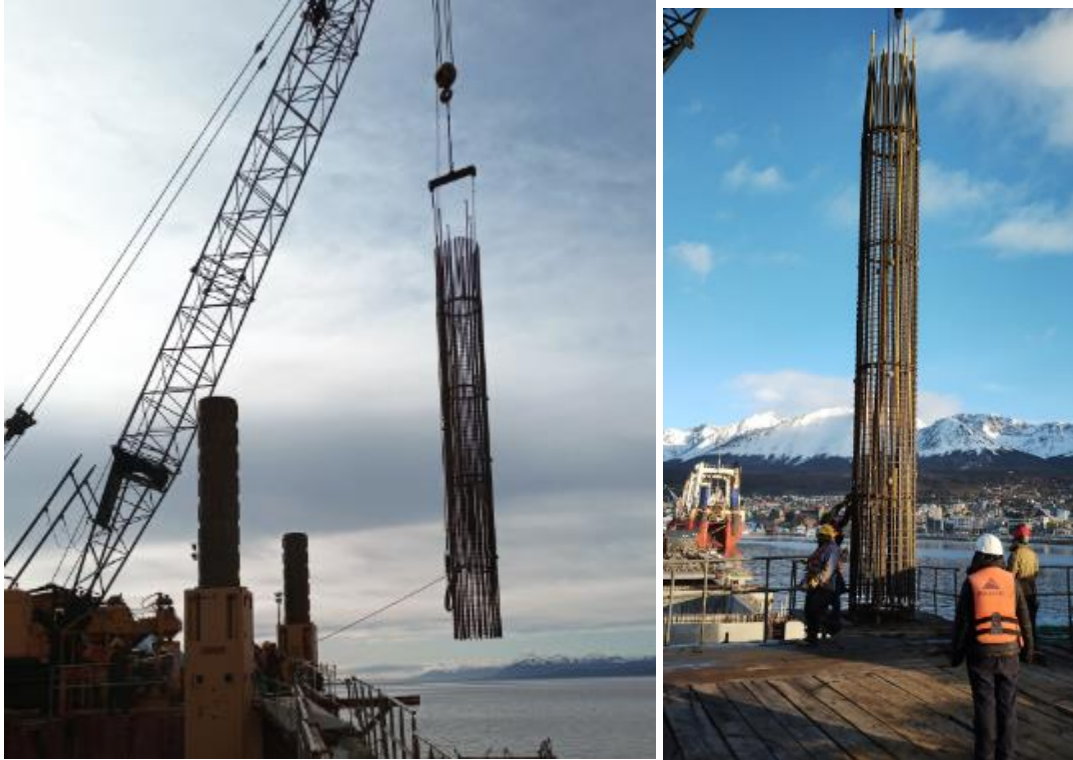
Secuencia de montaje de armadura de pilote.
