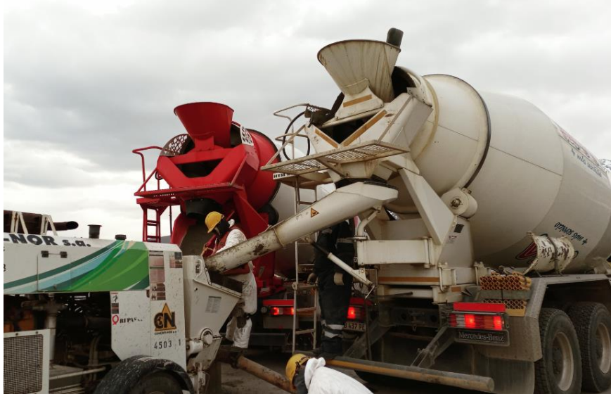
Descarga de hormigón con dos mixers en simultaneo en bomba de hormigón
