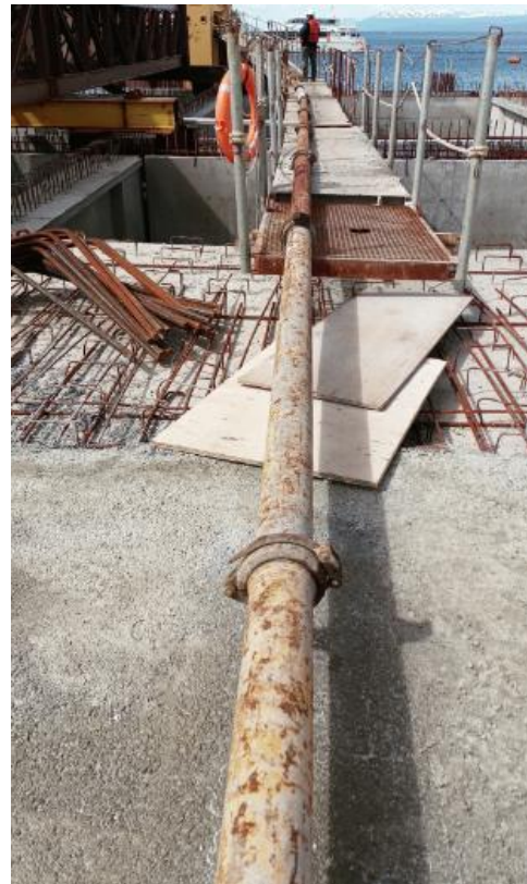
Recorrido de hormigón en tubería bomba arrastre de \phi 5 ".
