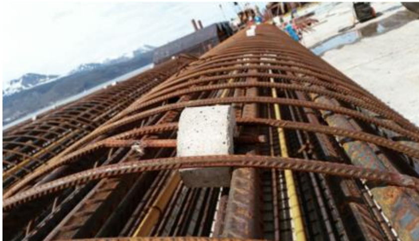
Imagen 6. Control de recubrimiento de pilote.
