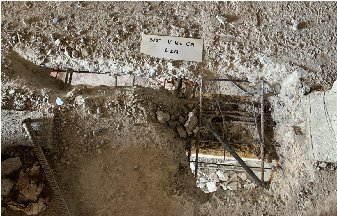
Fig.26 Armadura apoyo losa L2/L7 y viga V12c.
