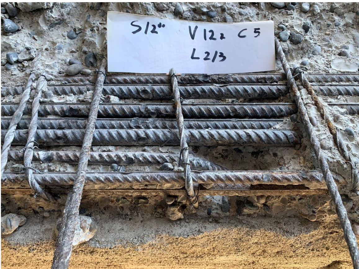
Fig.25 Armadura viga V12a.
