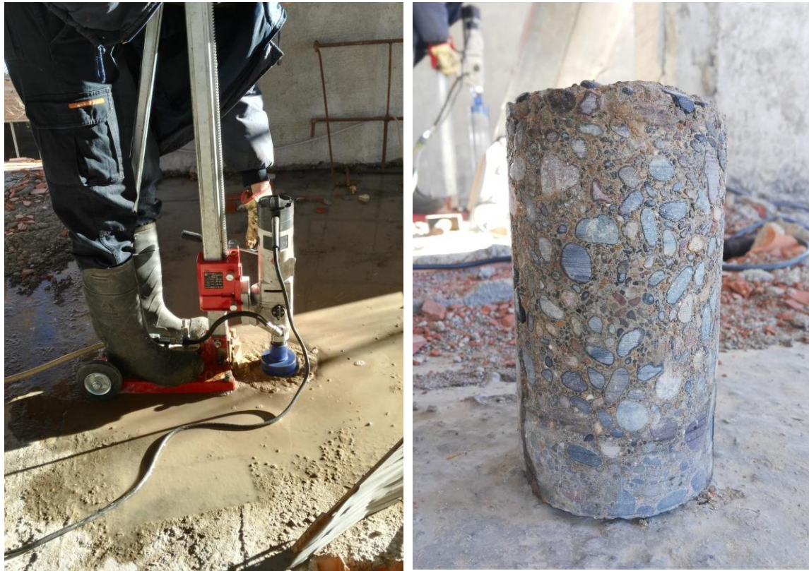
Fig. 22 Extracción de testigos en losas.
