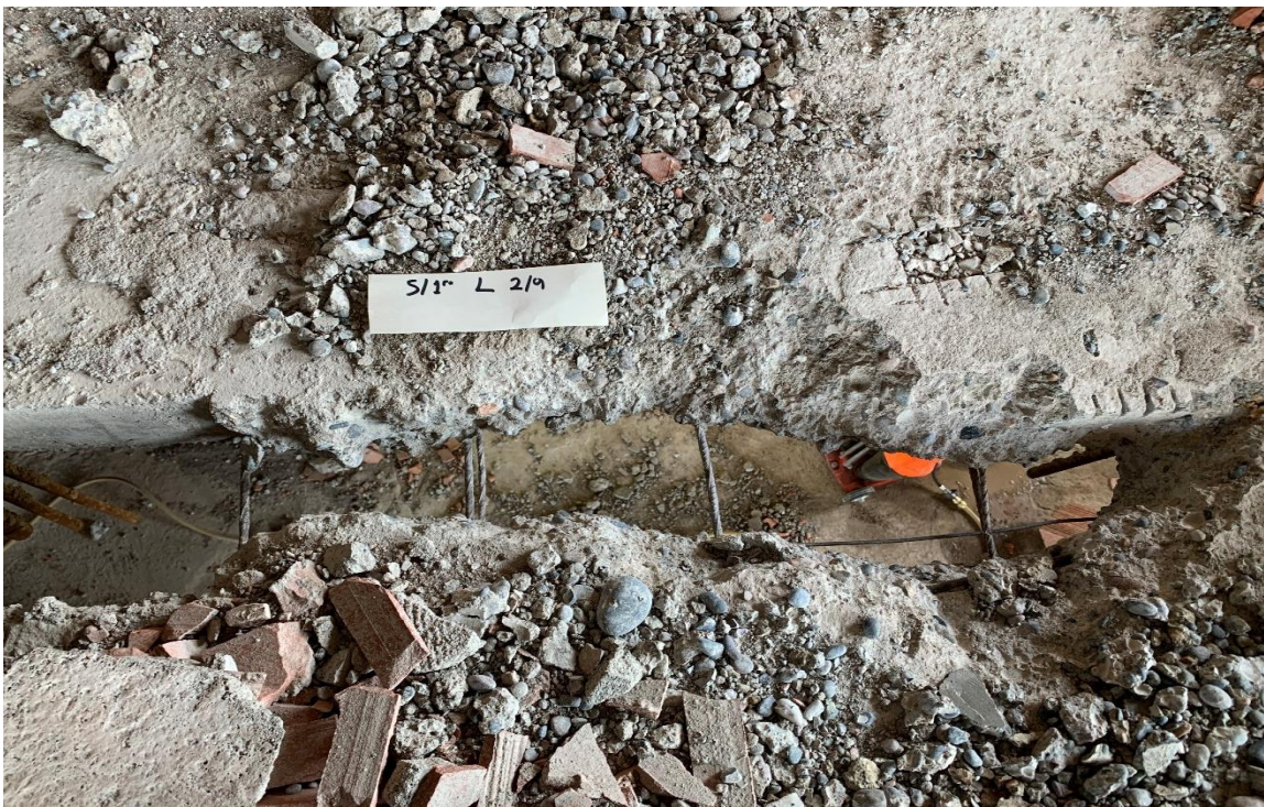
Fig.27 Armadura apoyo losa L2/L9.
