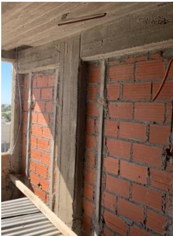
Fig. 19 Relevamiento de la estructura. Vigas y columnas.
