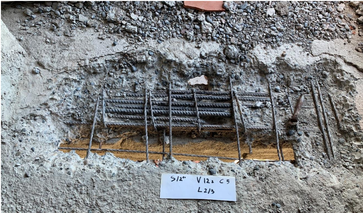
Fig.24 Armadura apoyo losa L2/L3 y viga V12a.
