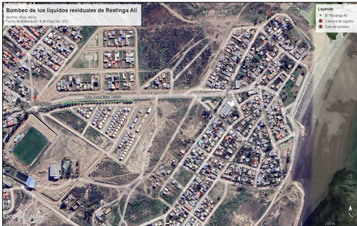
Ilustración 15: Puntos de referencia sobre la sala de bombeo de Restinga Alí y, su finalización para incorporarse a la red cloacal
