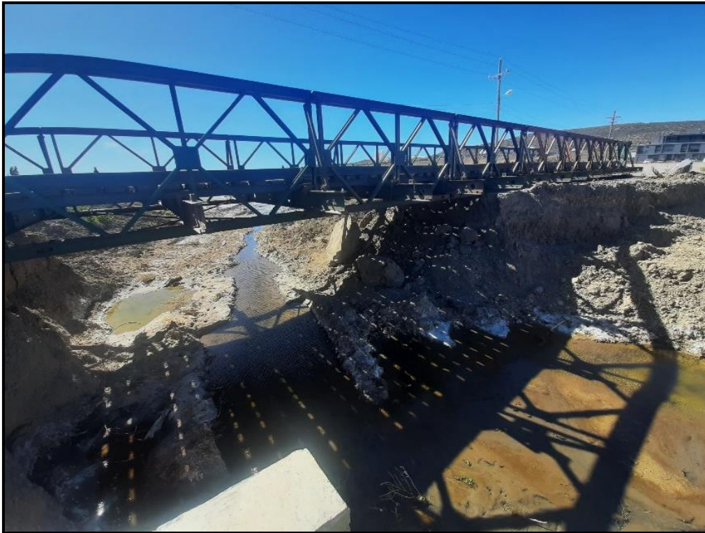
Imagen 45. (SE1) diciembre de 2022, puente Bailey sobre Arroyo La Mata.
