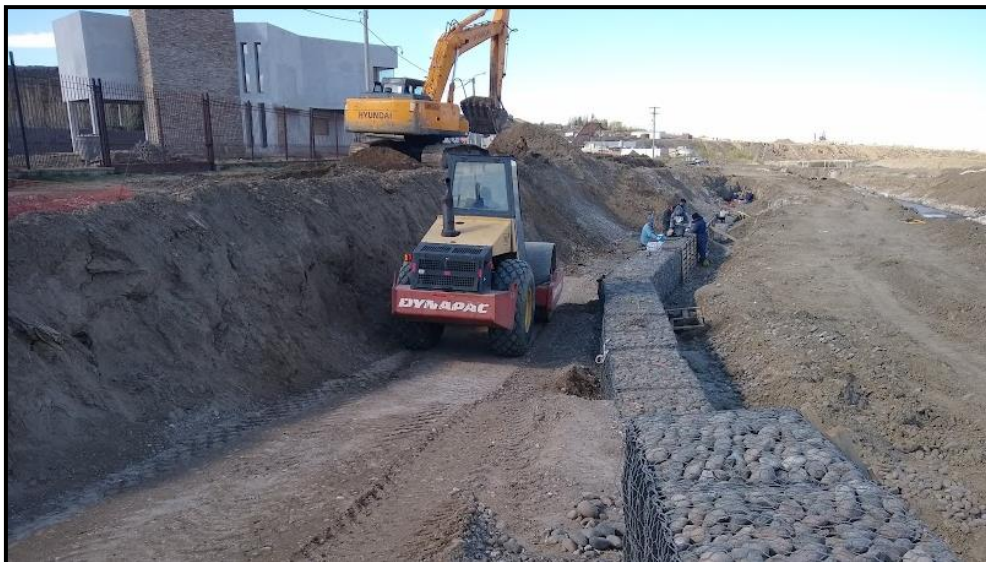
Imagen 82. Armado de la primera fila de gaviones. Los elementos colocados son de 1x1x1 m.
