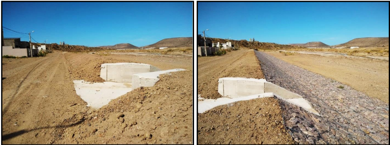
Imágenes 74 y 75. Colchonetas rellenas y obra de arte de hormigón armado para vertido de aguas hacia el arroyo.
