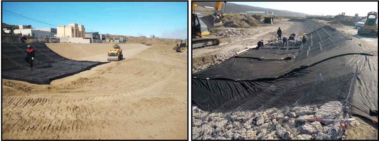
Imágenes 72 y 73. Colocación de geotextil y jaula de alambre para su posterior llenado. Detrás se puede ver la máquina compactando el suelo previa colocación del geotextil.
