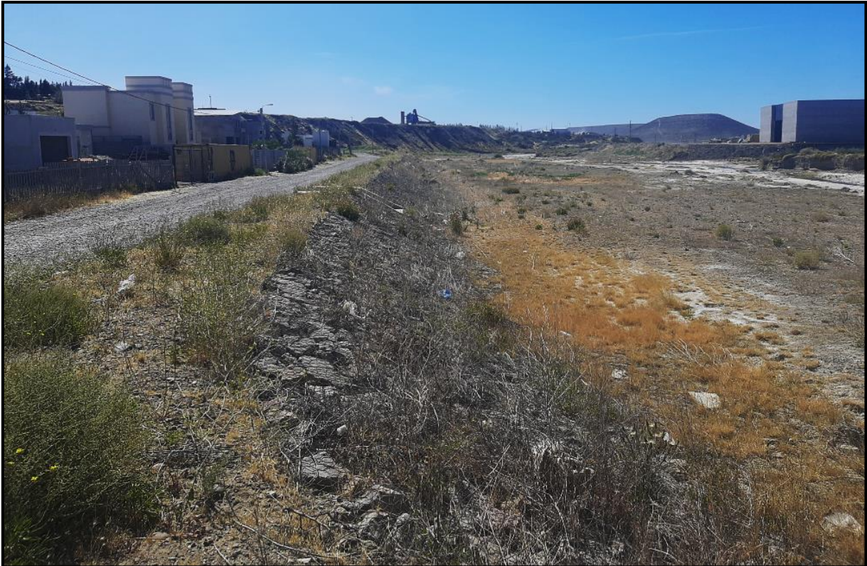
Imagen 43. (SE1) diciembre de 2022, estado de la obra 1ª etapa de protección de margen izquierda.
