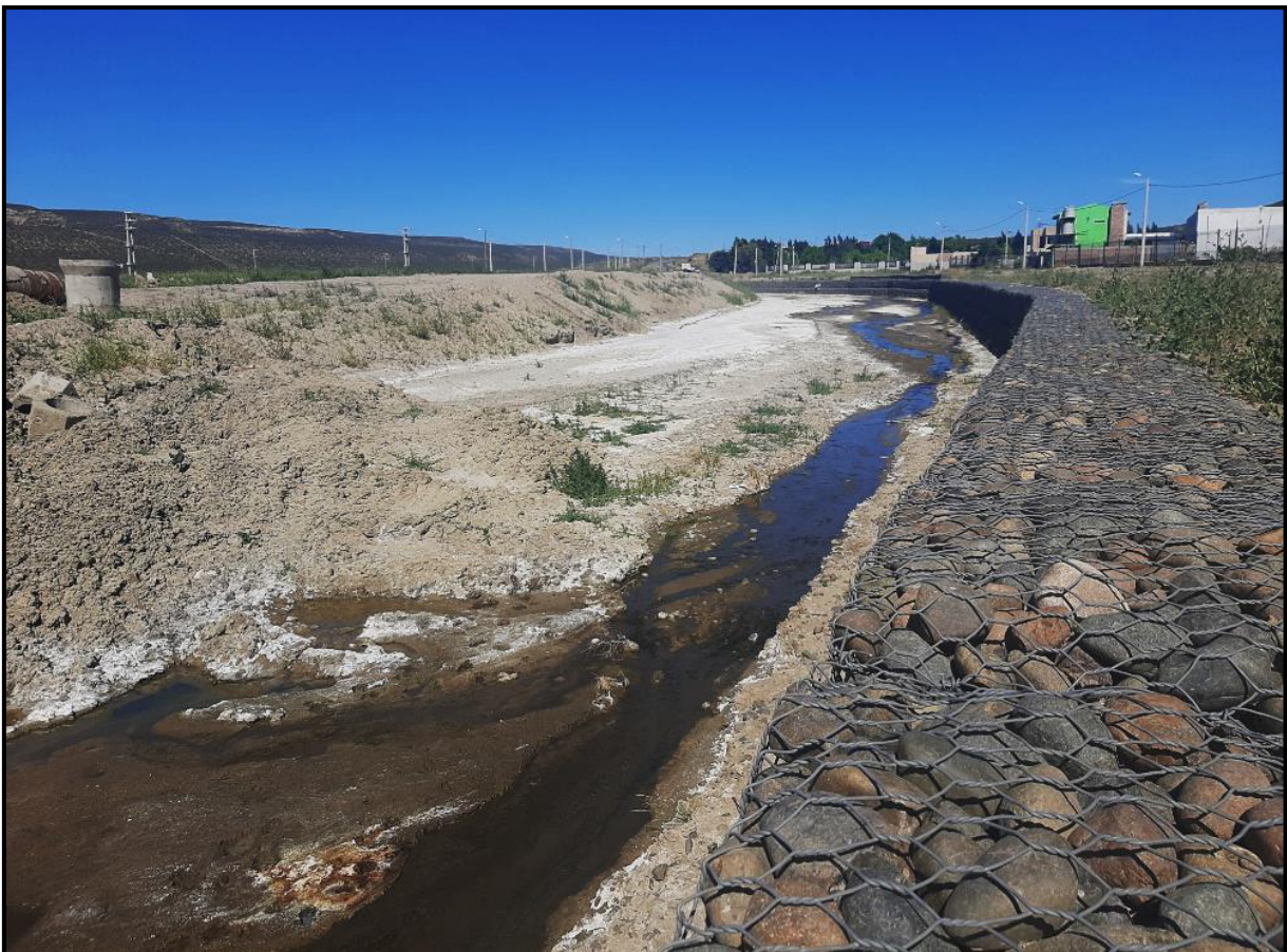
Imagen 44. (SE1) diciembre de 2022, estado de la obra 2ª etapa de protección de margen izquierda.
