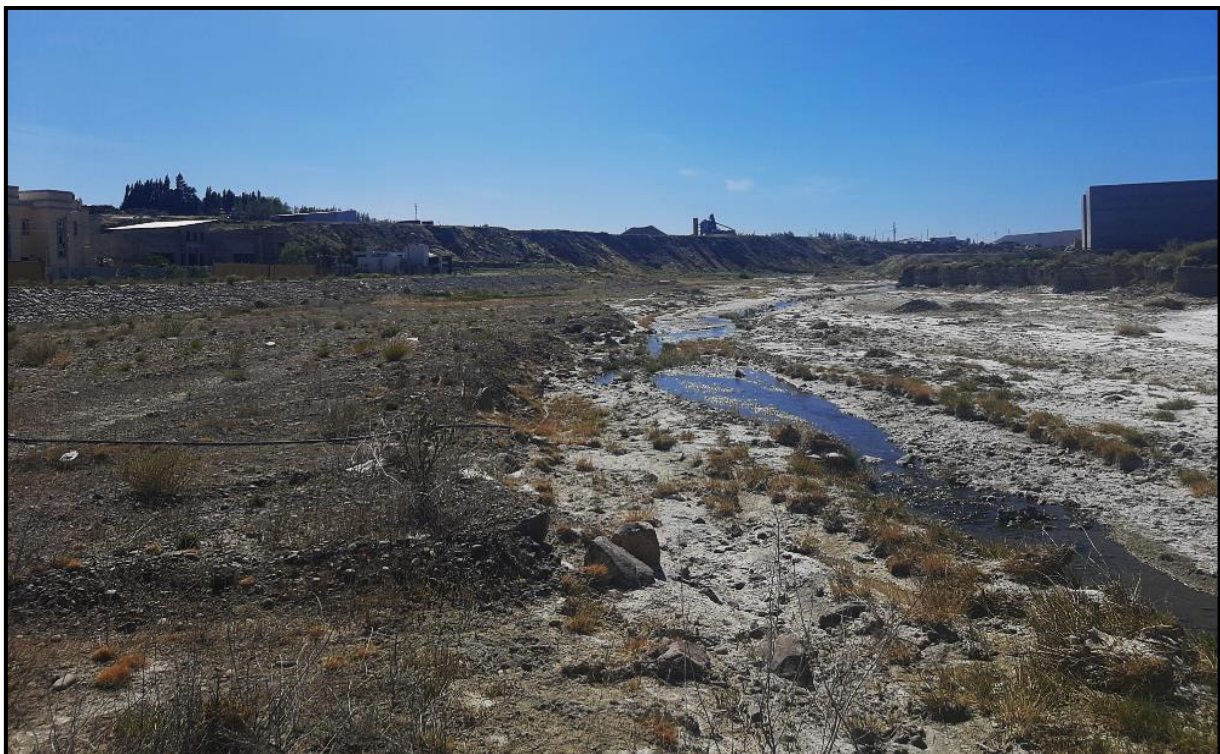
Imagen 46. (SE1) diciembre de 2022, vista aguas abajo del puente Bailey sobre Arroyo La Mata.
