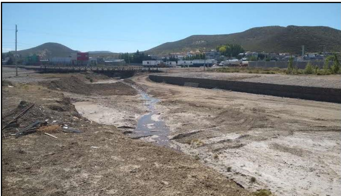
Imagen 95. Avance de la tercera etapa de reparación.
