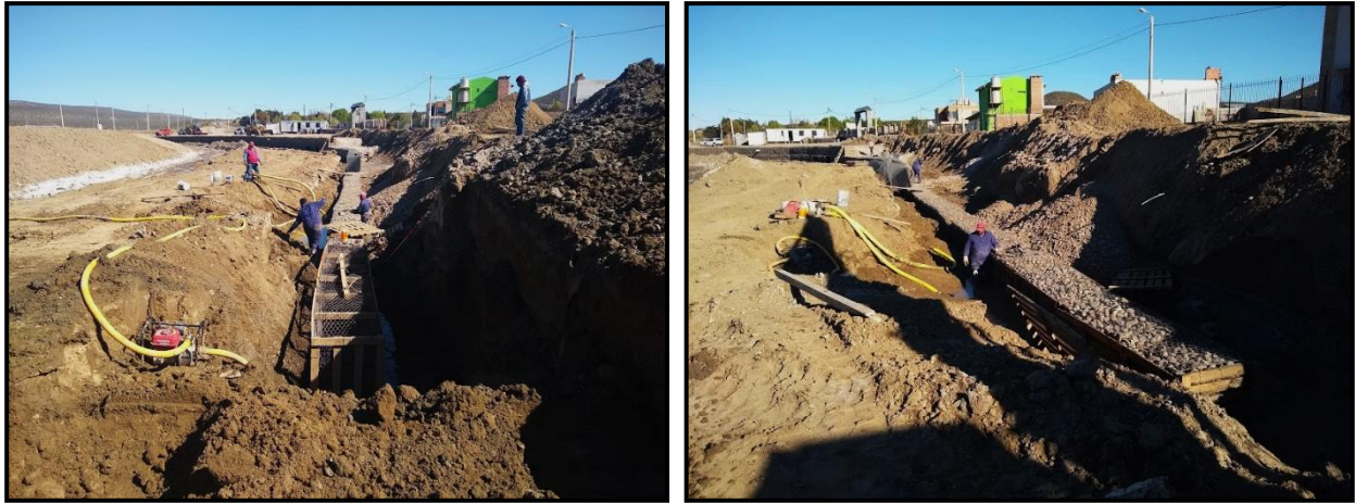
Imágenes 80 y 81. Excavación para enterrar los gaviones de base para el muro.
