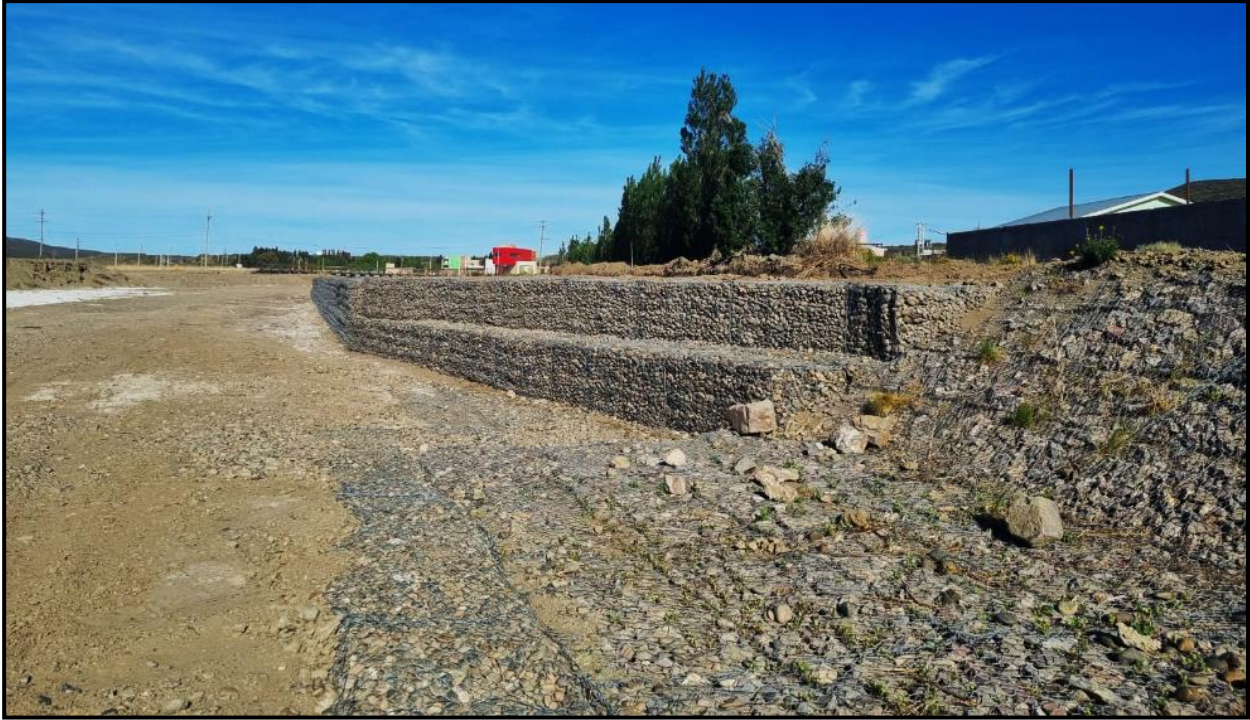
Imagen 99. Zona de encuentro entre primera y tercera etapa. Vista aguas arriba.
