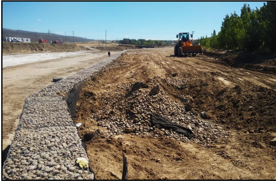
Imagen 96. Relleno del trasdós del muro, sobre margen izquierda.
