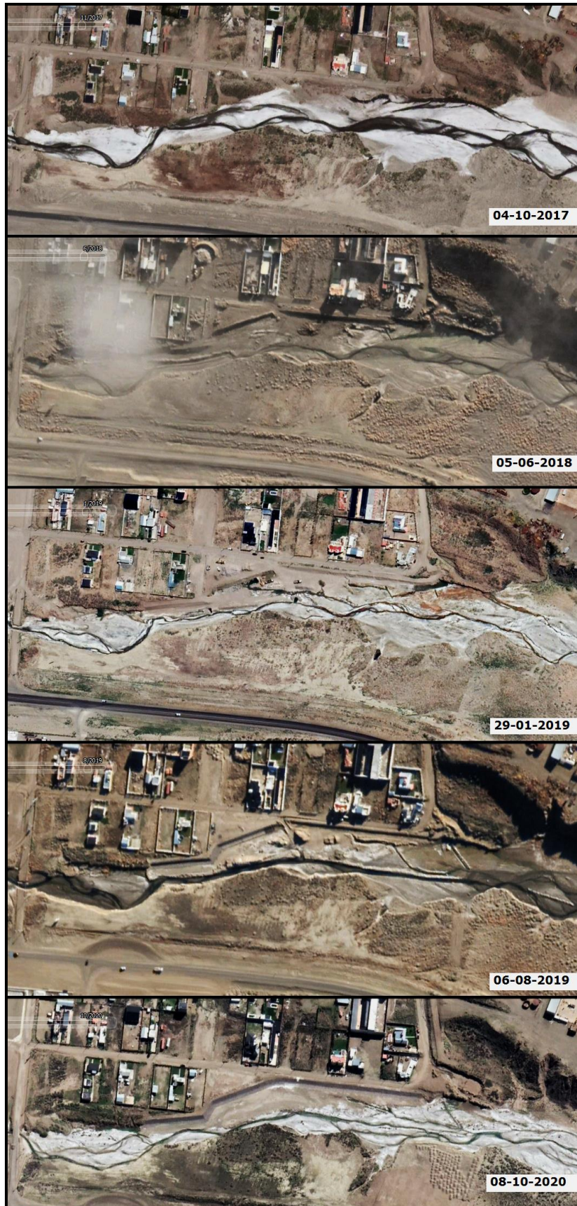
Imagen 71. Avance de la primera etapa de la reparación de la margen izquierda, barrio Los Arenales.
