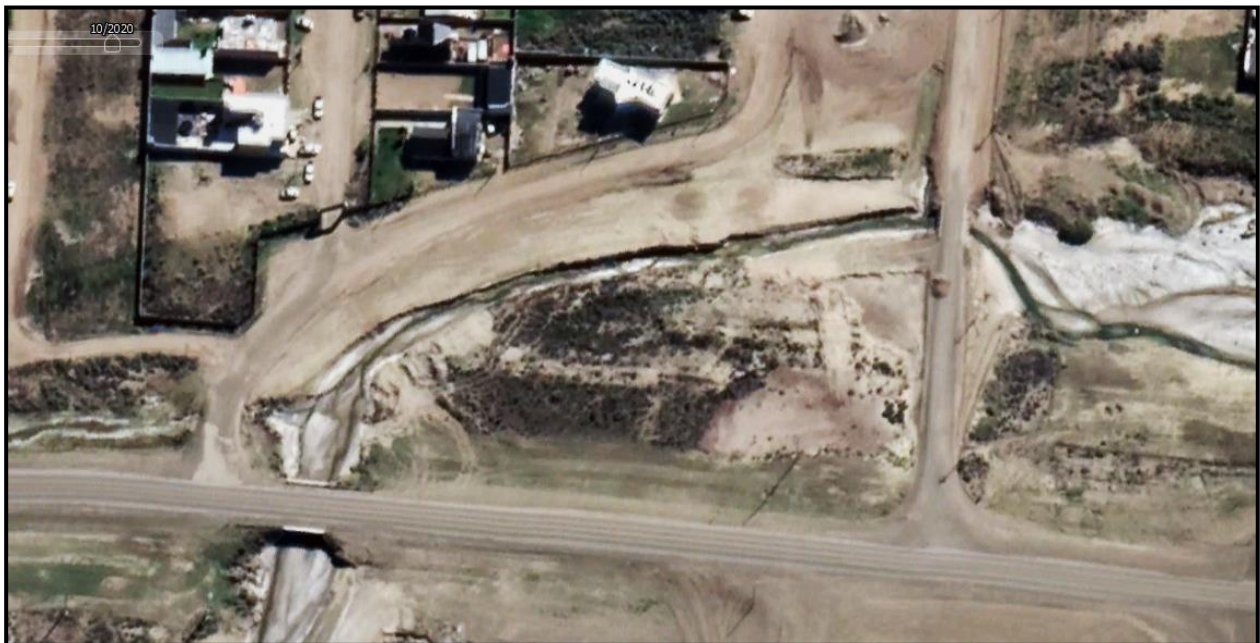
Imagen 78. Inicio de las obras de reparación de la margen izquierda (octubre 2020).
