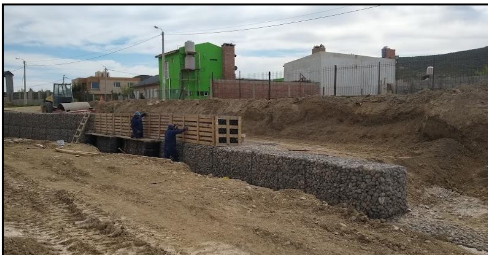
Imagen 83. Armado de segunda fila de gaviones. Puede apreciarse el encofrado de madera que se utiliza para rellenarlos adecuadamente.
