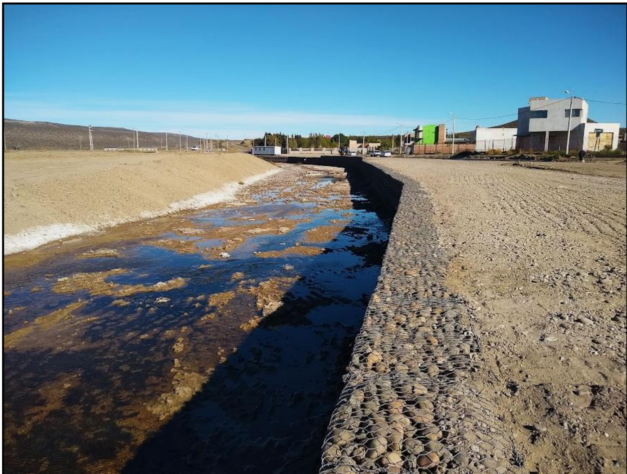
Imagen 85. Obra finalizada. Vista hacia aguas arriba. A la derecha de la foto, la margen izquierda protegida con muro de gaviones. A la izquierda de la foto la margen derecha que fue recompuesta con material granular y reestablecido el talud.
