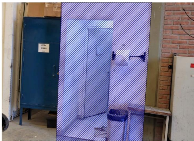
Imagen n° 8: Sector de baño existente a demoler
