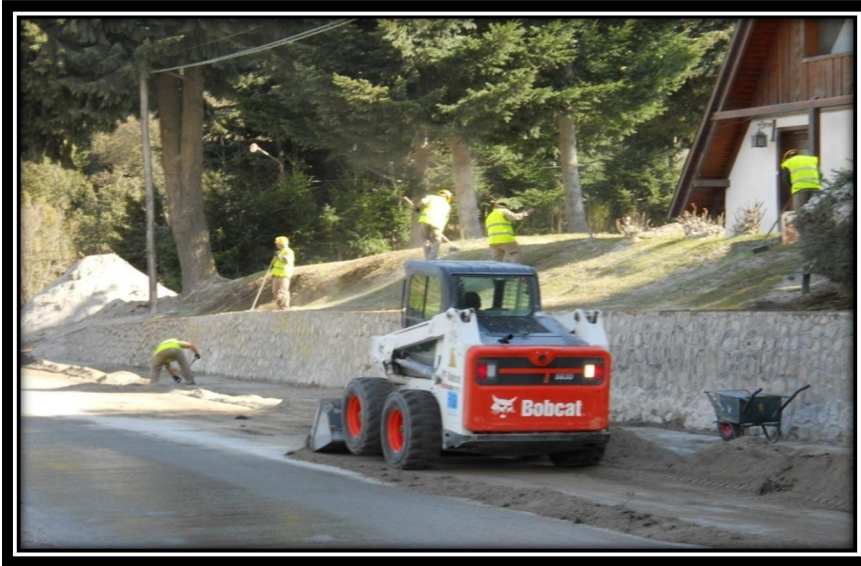
Foto 9: Cuadrillas de limpieza trabajando. Extraída de Informe de Limpieza de ceniza, Unidad Ejecutora, Informe de Gestión, 2012.
