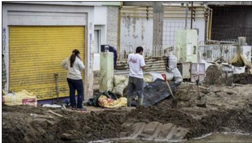
Imagen 13: Ingreso de agua y barro en viviendas Fuente: Diario El Patagónico, 2017.
