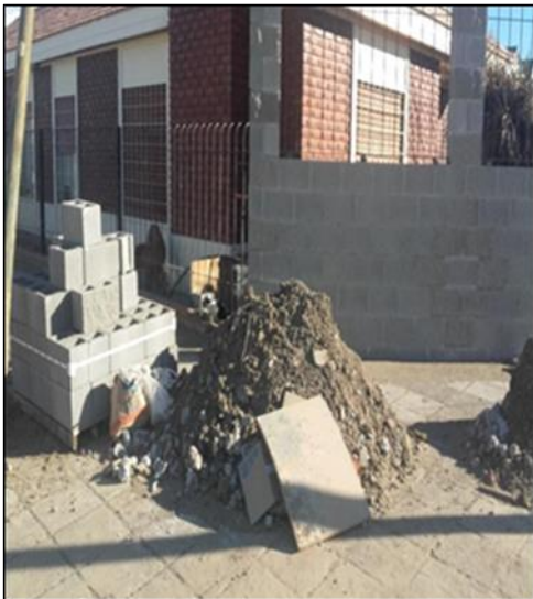
Imagen 10: Construcción de paredones altos Fuente: elaboración propia, 2017.
