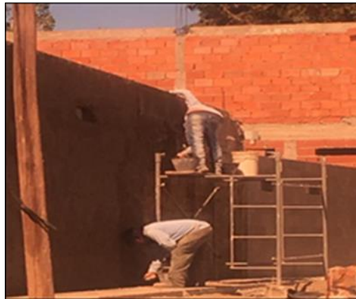
Imagen 12: Construcción de paredones altos Fuente: elaboración propia, 2019.
