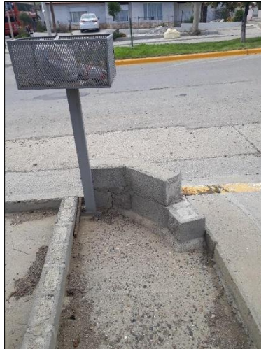
Imagen 26: Contención con bloques al ingreso de vivienda Fuente: elaboración propia, 2019.
