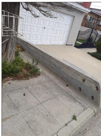
Imagen 25: Cordón de contención al ingreso de la vivienda Fuente: elaboración propia, 2019.
