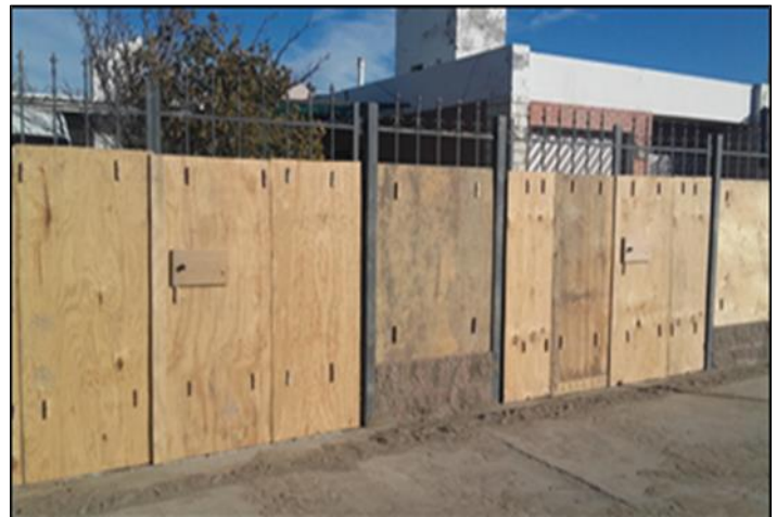
Imagen 11: Construcción de paredones altos Fuente: elaboración propia, 2017.
