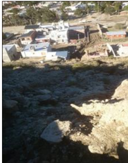
Imagen 24: Desprendimiento en ladera Fuente: Amaya, Diego. 2017
