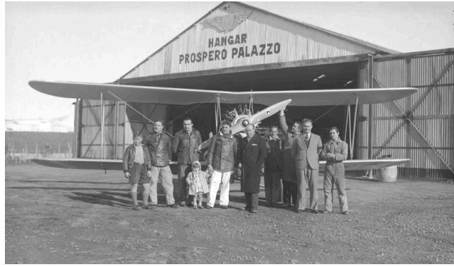
Figura 24. Hangar Próspero Palazzo en el Aeroclub de Comodoro Rivadavia.
