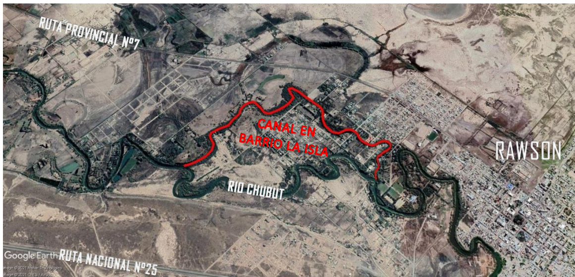
Imagen 1. Ubicación general Ciudad de Rawson (en rojo se marca el canal del barrio la Isla)
