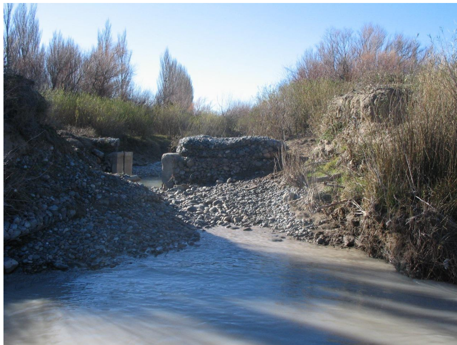
Imagen 15. Estructura de regulación de caudal al inicio del brazo del río Chubut (tomada por el Dr. Gabriel Kaless).
