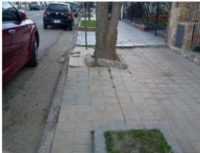
Fig.2.13- Deformaciones diferenciales producidas en zona de suelos expansivos (GAclay a 1m de profundidad)
