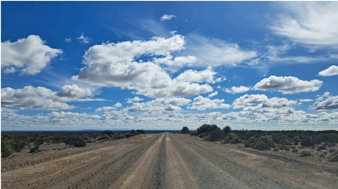
Fig. N° 22. Estado de los caminos de la Meseta Central de Chubut
