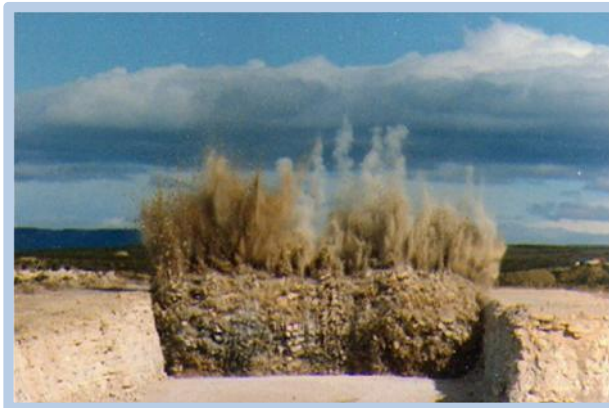
Figura 3.2 Voladura en cantera de caliza ubicada en Teta de Pineda, Chubut
