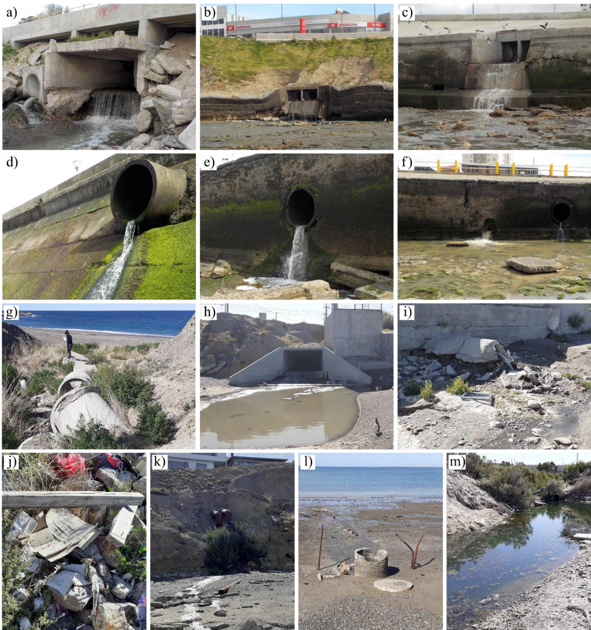
Figura 8. Efluentes que desembocan sobre la línea de costa: a) Avenida Polonia Fortunato Carante; b) Ramos Mejía; c) Ceferino Namuncurá - Av. Ducós; d) Colector Las Torres; e) Colector Socios Fundadores; f) Calle Mitre 1 y 2; g) Escuela BM; h) Calle Quintana; i) Calle Quintana 2; j) Hospital Alvear tapado por basura; k) Barrio Km 4 - Walmart; l) Tapa de cloaca Km 5; m) Desagüe Km 5.
