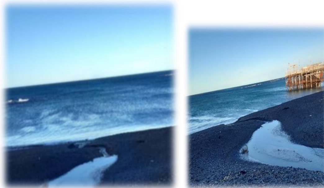
Figura 26: Desagüe pluvial y cloacal a metros del muelle en la zona costera (Paseo costero). Fecha enero 2021.
