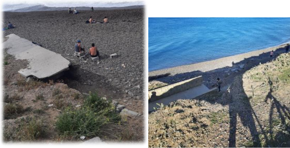
Figura 28: Estructuras y senderos de acceso a la playa. Fecha enero 2021.
