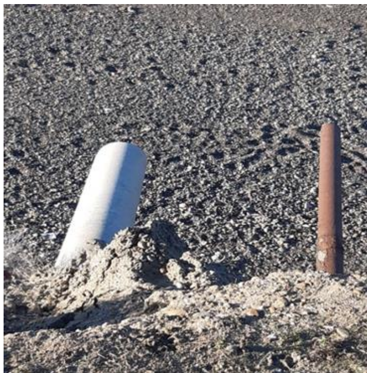
Figura N°18: Caños abandonados pertenecientes a la actividad hidrocarburifera y caño pluvial antiguo sobre acantilados de la playa.
