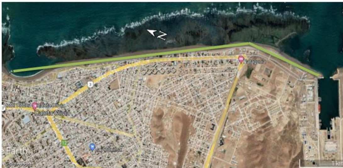
Figura 8 El trayecto total de la franja paseo costero de la ciudad que abarca un total de 4,09 km de extensión total. Fuente: Google Earth. Fecha: Diciembre 2020.
