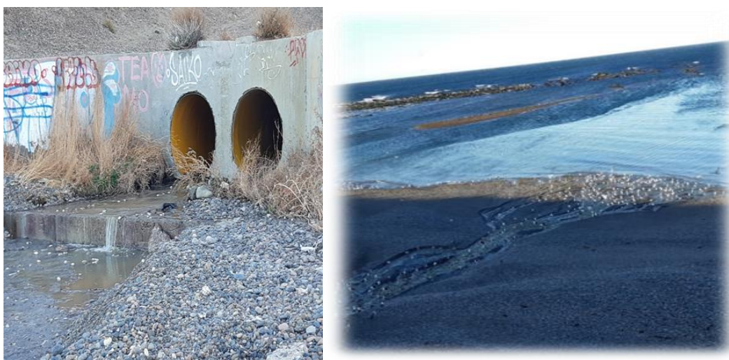
Figura 13. Imagen izquierda desagüe pluvial, imagen derecha desagüe cloacal. Fecha diciembre 2020. Fuente: Propia
