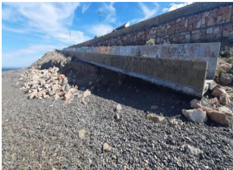
Figura 29. Muros de contención que disminuyen la erosión. Fecha: noviembre 2020
