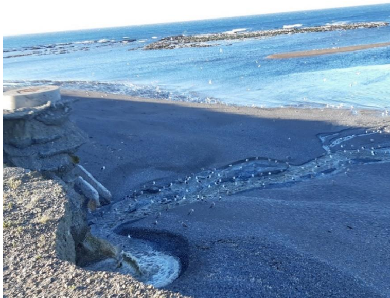
Figura 27. Planta de tratamiento. Fecha: enero 2021.
