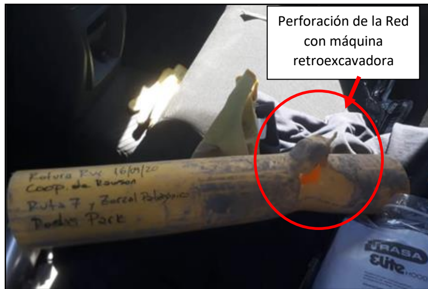
Imagen N°20: Rotura de la Red de alimentación de polietileno \varnothing 90mm.
