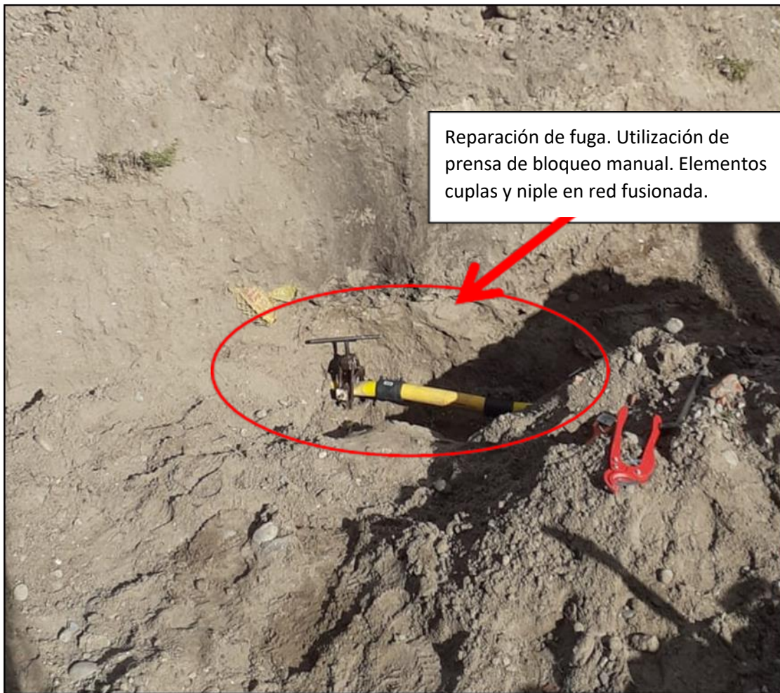
Imagen N°23: Reparación de fuga de red de polietileno \varnothing 90mm.
