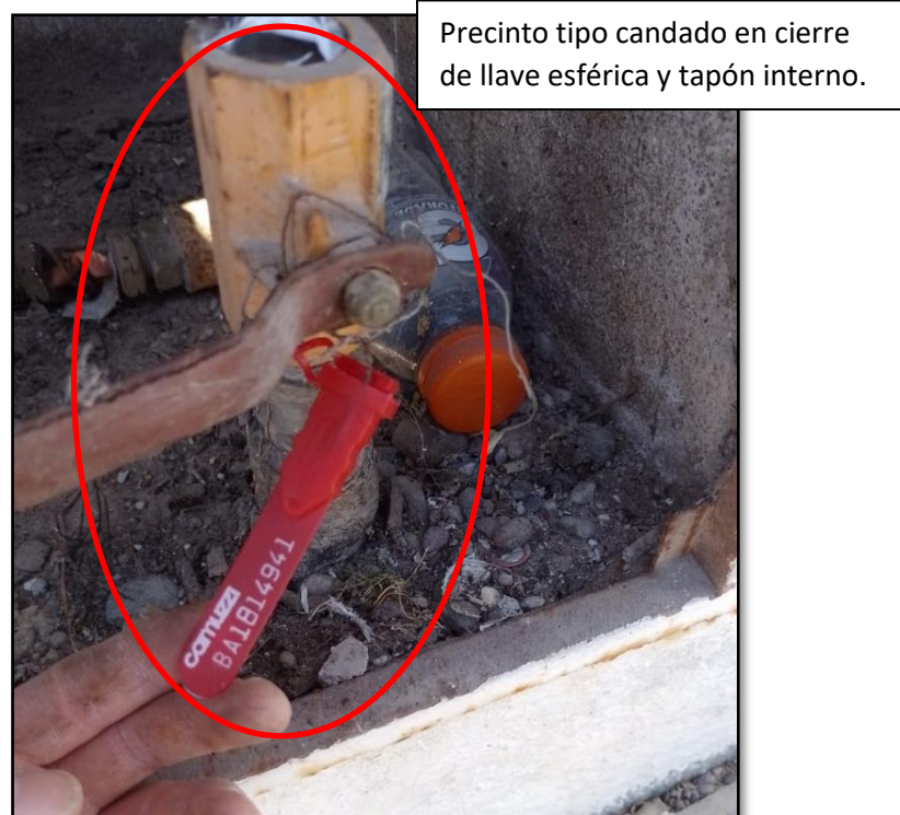
Imagen N°30: Cierre de válvula y precintado.
