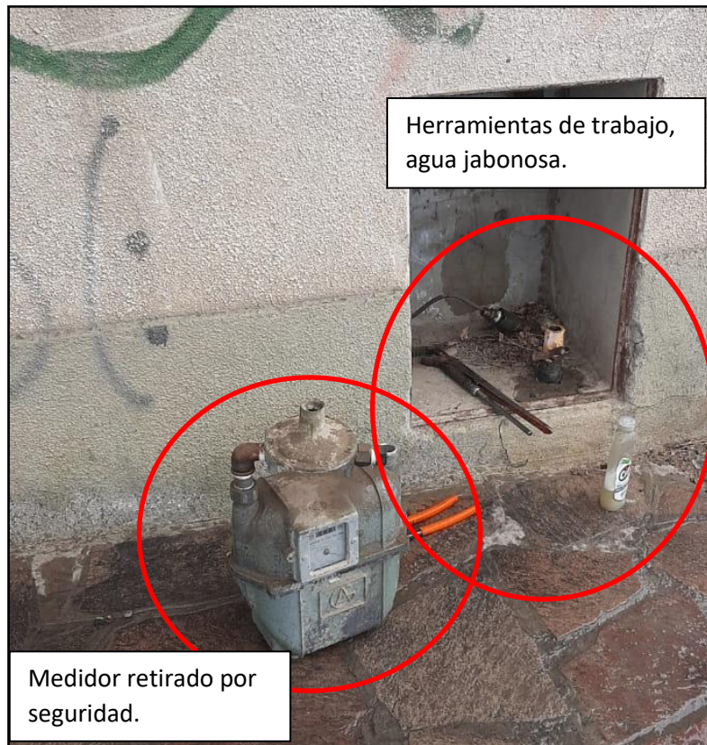
Imagen N°29: Retiro de medidor y herramientas utilizadas.
