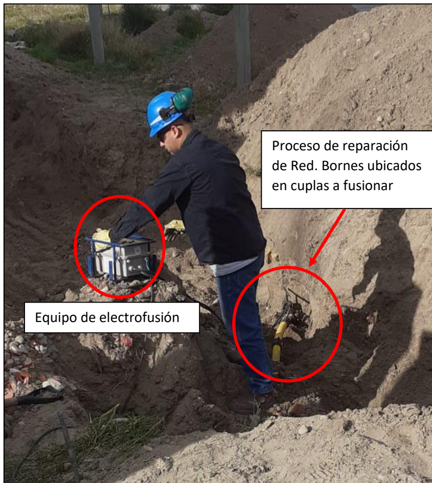
Imagen N°22: Reparación de Red según normativa ISM-139/ I OR-087.
