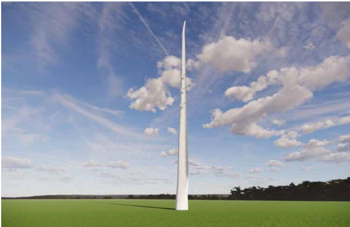
Figura 25. PROPUESTA DE REUTILIZACIÓN DE PALAS EÓLICAS PARA TENDIDO DE LÍNEAS ELÉCTRICAS. FUENTE: RE-WIND
