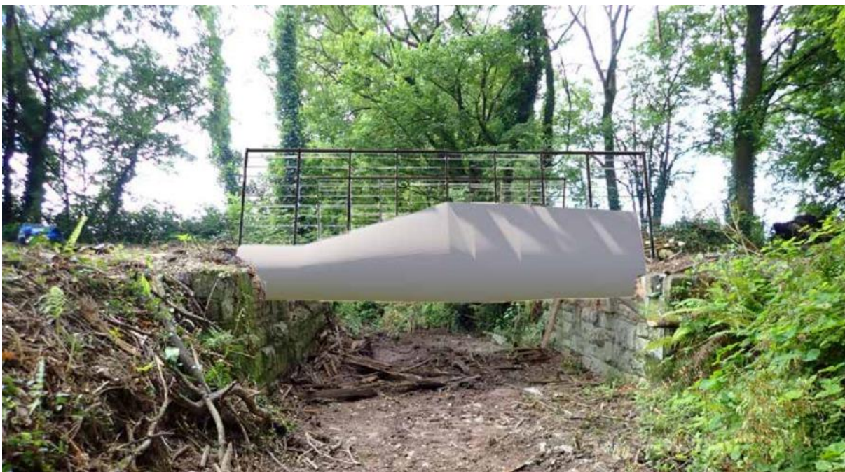
Figura 23. PROPUESTA DE PUENTE A PARTIR DE REUTILIZACIÓN DE PALAS EÓLICAS. FUENTE: RE-WIND.
