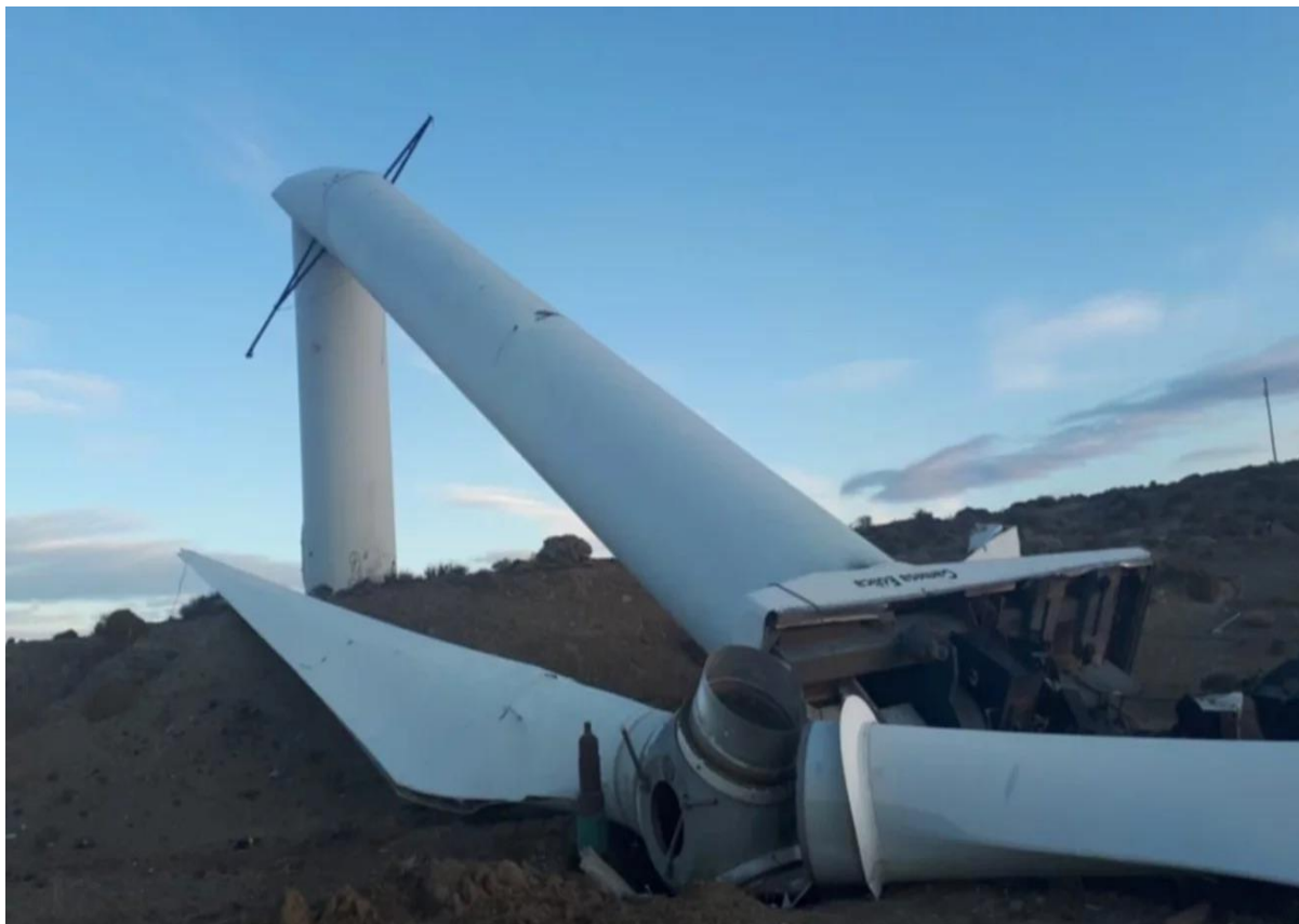
Figura 12. AEROGENERADOR DEL ANTIGUO PARQUE ANTONIO MORAN DERRIBADO POR FUERTES VIENTOS. FUENTE: EL CHUBUT, 2020.
