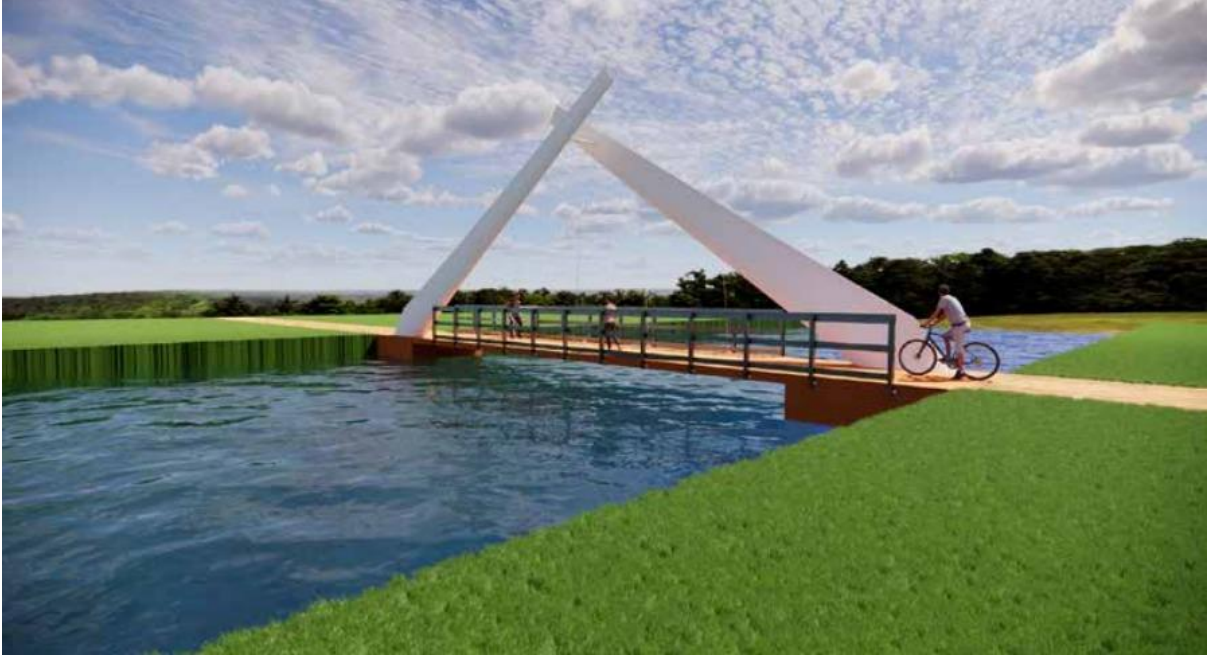
Figura 24. PROPUESTA DE PUENTE A PARTIR DE REUTILIZACIÓN DE PALAS EÓLICAS. FUENTE: RE-WIND.
