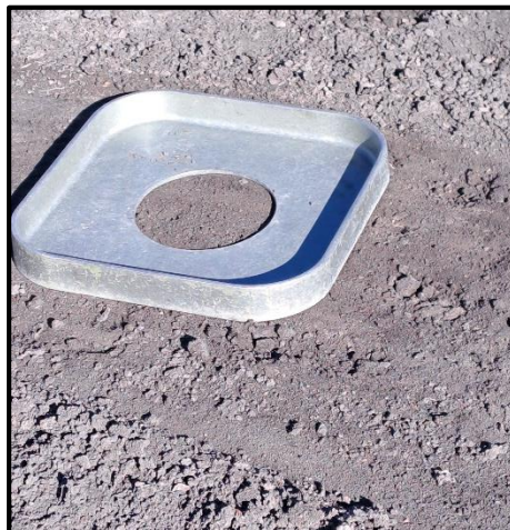
Imagen 48: Colocación de la bandeja de hierro en el terreno.
