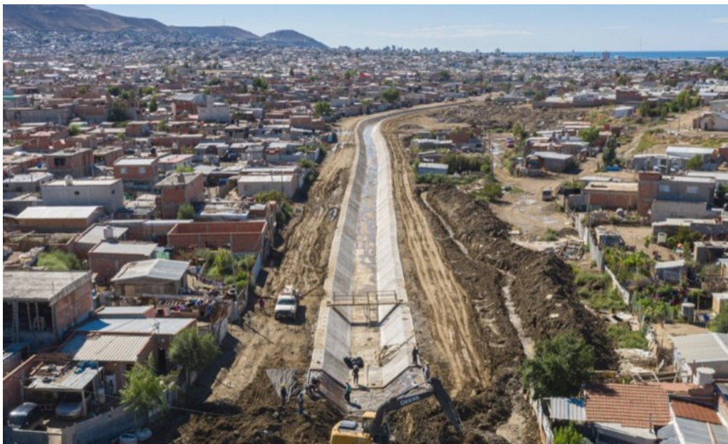
Figura 20. Entubado en proceso de realización
