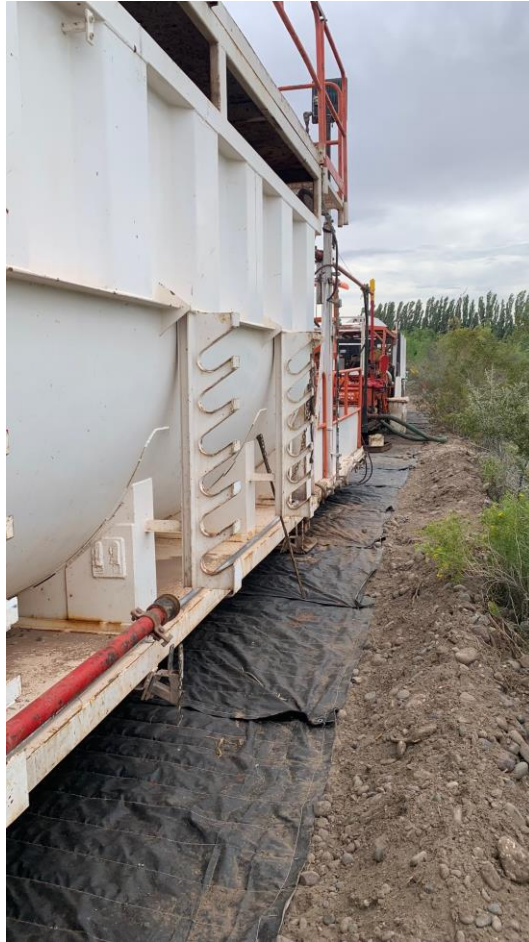
Figura N° 32. Equipo de Pulling. Tanque de combustible
