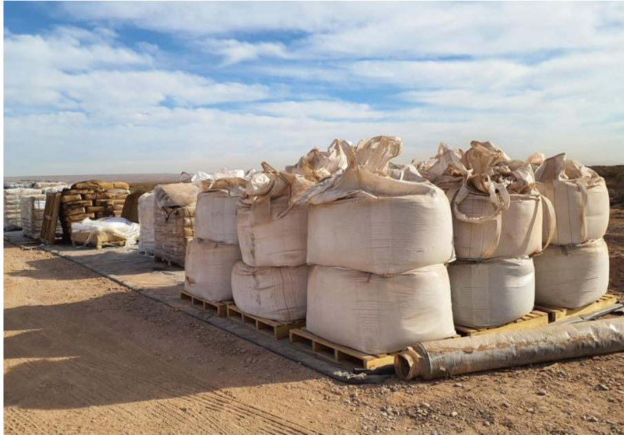
Figura N° 42. Equipo de Perforación. Mantas debajo productos químicos
