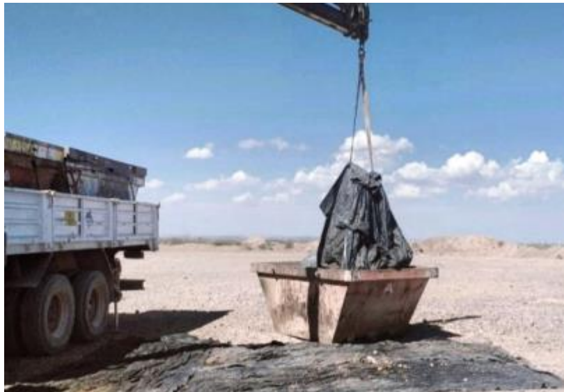
Figura N° 16: Retiro de mantas contaminadas. Fuente: Instructivo OPERACIÓN DE MANTAS ORGÁNICAS OLEOFÍLICAS 3923-SP-MF-IT-001 Revisión 3 AESA S.A
