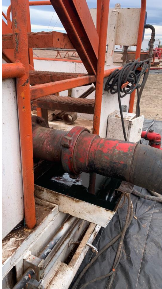
Figura N° 33. Equipo de Pulling. Acometida de manguerote
