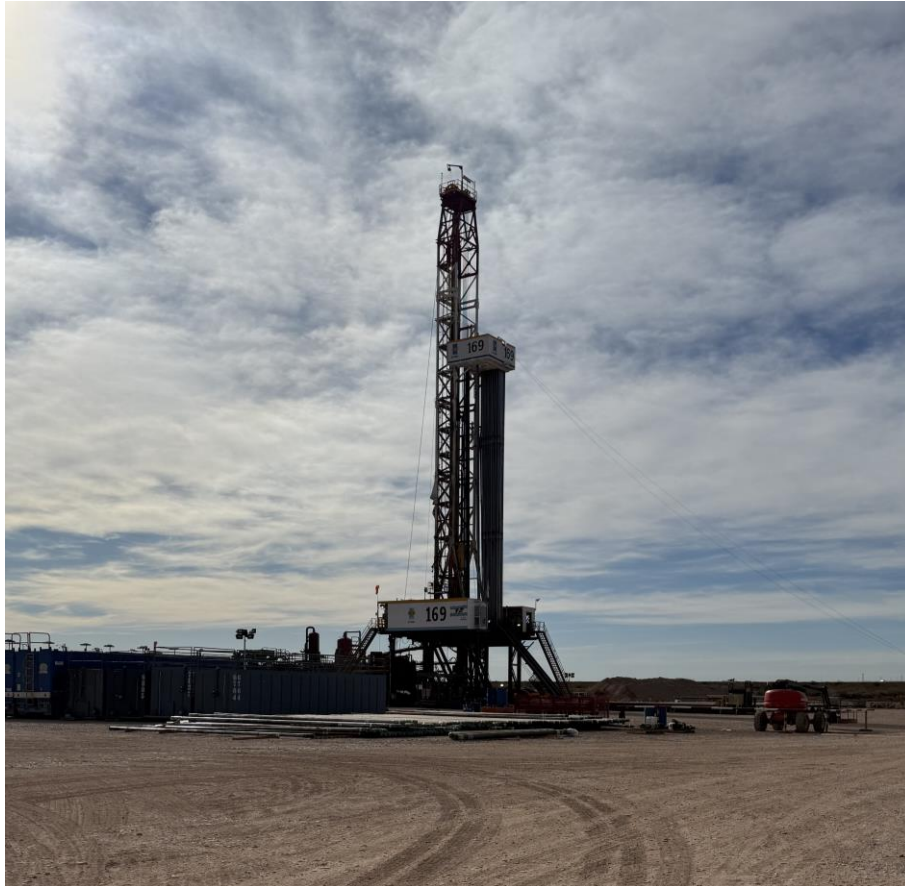
Figura N° 26: Equipo de perforación. DLS 169. Fuente: Elaboración propia. (2024)
