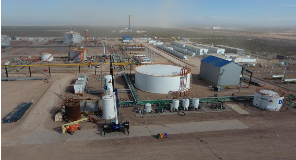
Figura N° 14: Planta de Tratamiento de Crudo (PTC) Loma Campana. 2016. Fuente: SharePoint Data Management YPF S.A.
