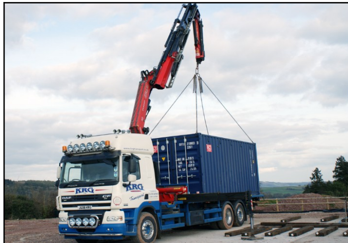
Figura 51: instalación de ModularDigester de Empresa Earthlee.
