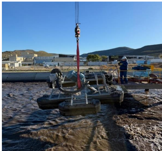
Fig A9: Tareas de mantenimiento de equipo agitador de superficie. Fecha: 22/05/2025.
