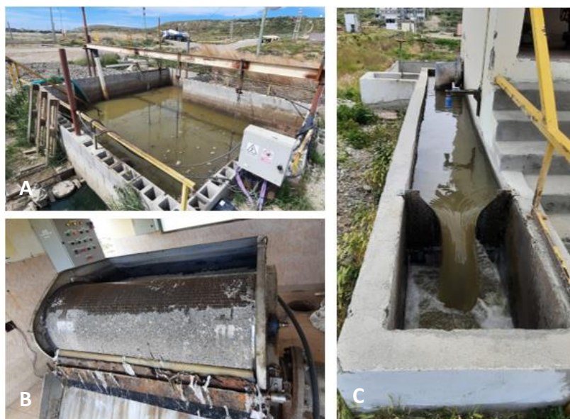
Fig 4: Etapas de pretratamiento de la PTEC de Rada Tilly. (A) Cámara de crudo. (B) Tamiz rotativo. (C) Desarenador. Fuente: Elaboración propia.
