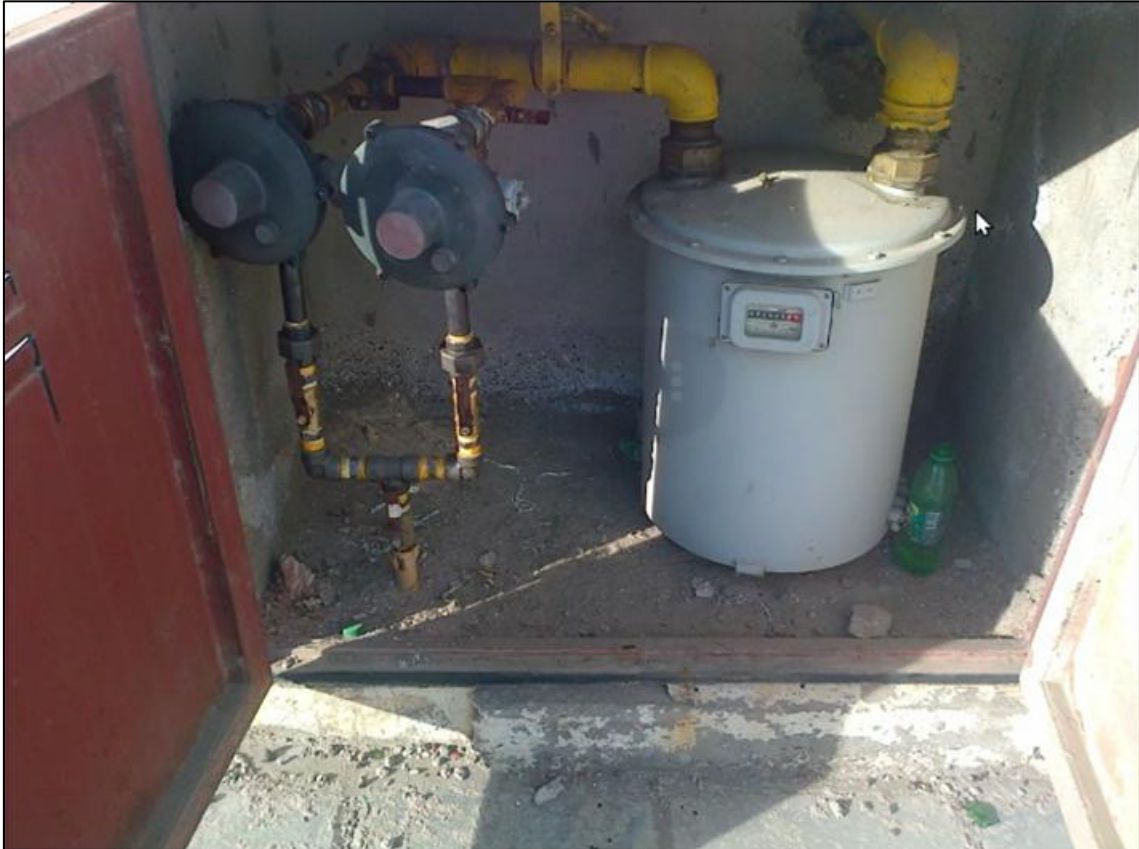
Benítez, C., & Burgos, A. (2025). Ejemplo de regulador de 70 m 3 /h con medidor [Fotografía]. Archivo personal
