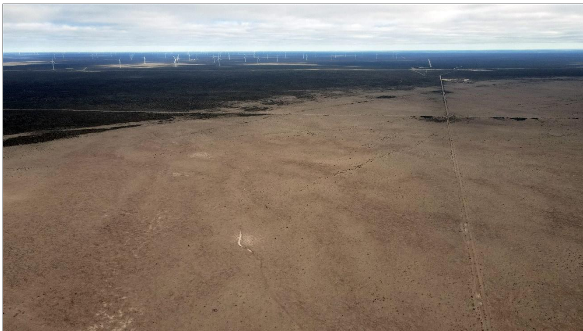
Figura 43: área afectada por el incendio del 01/01/2022 cercana a un parque eólico.
