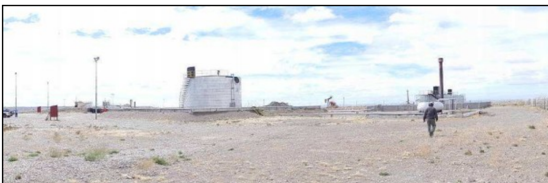
Figura 26: Planta de recepción y despacho Las Mesetas III (vsta sector trasero).
