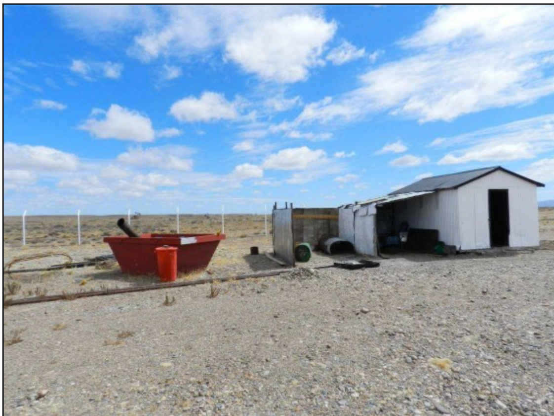
Figura 27: Galpón. Acopio de materiales.
