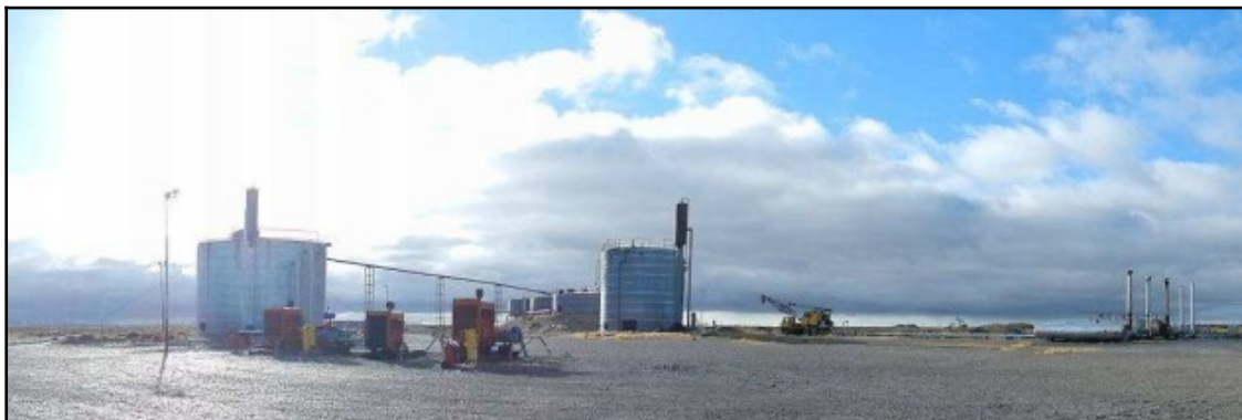
Figura 24: Vista de la Planta de tratamiento (vista sector trasero).
