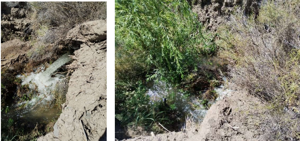
Figura 7. Fotografía del drenaje existente al final del recorrido del canal.
