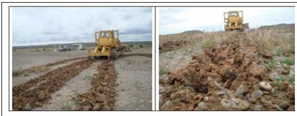
Figura 18: Ejemplo de escarificación de superficies compactadas con máquinas (Fuente: Ferro, L. 2013. Cantera Gaiman).
