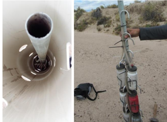
Figura 8: Izq.: Interior de la estación de aforo. Der.: Detalle con las botellas recolectoras
