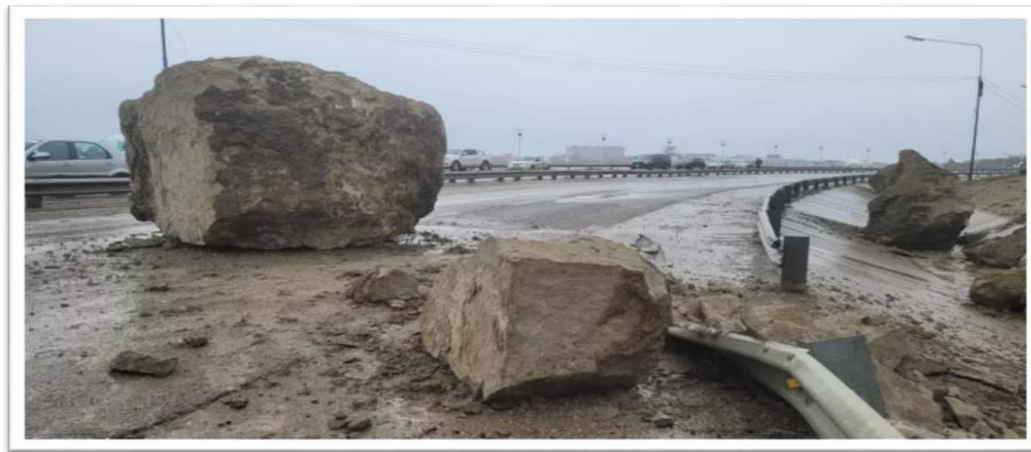
Figura 2: Desprendimiento de rocas por lluvia extraordinaria
