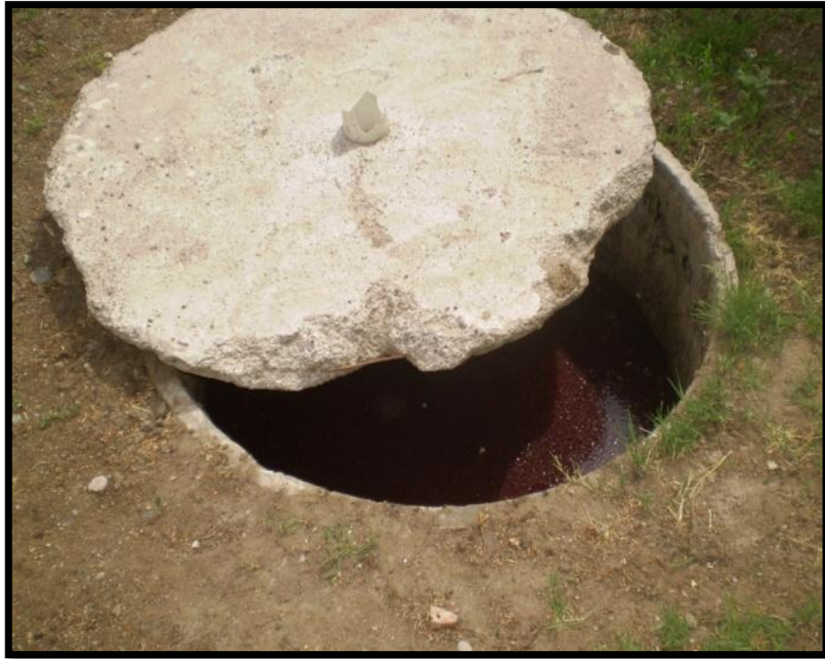
Imagen 24: Cámara previa a las lagunas.
