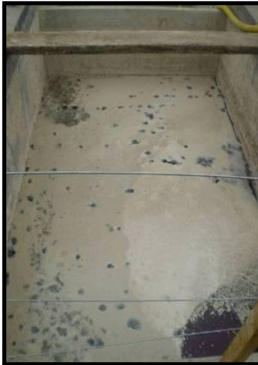
Imagen 9: Segundo compartimiento del sedimentador.
