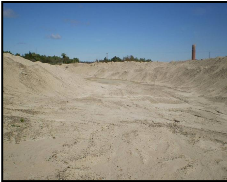
Imagen 51: Movimiento de suelos para construcción de una tercera laguna.
