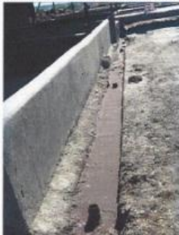
FOTO 17. Recolección de efluente de las piletas.
