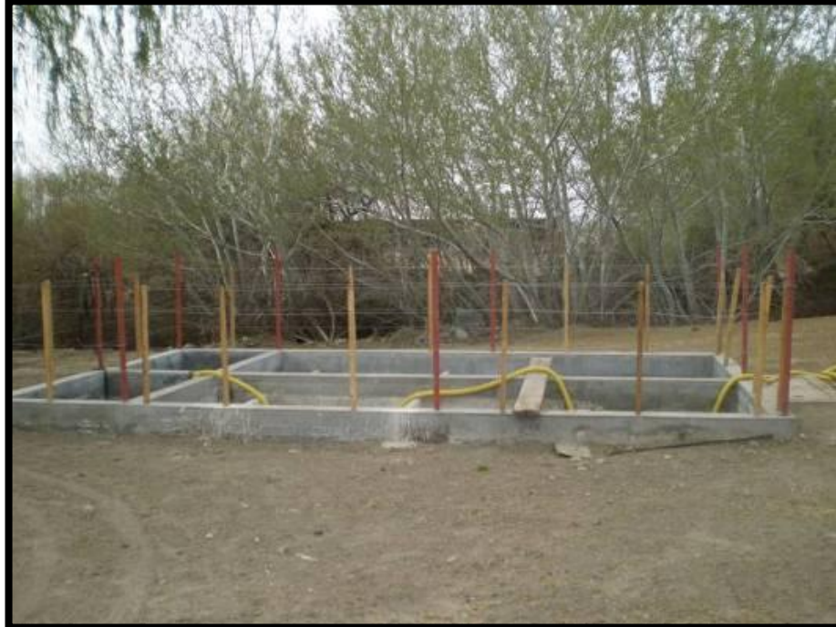
Imagen 7: Unidad de sedimentación.
