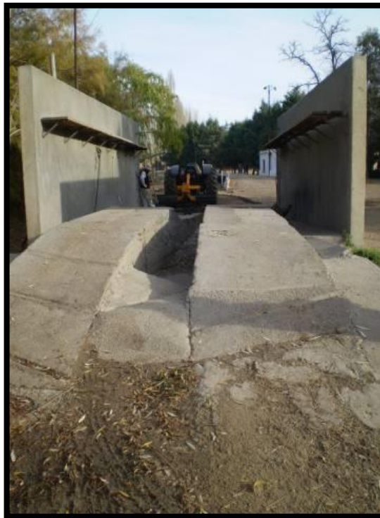
Imagen 15: Lavadero de camiones.
