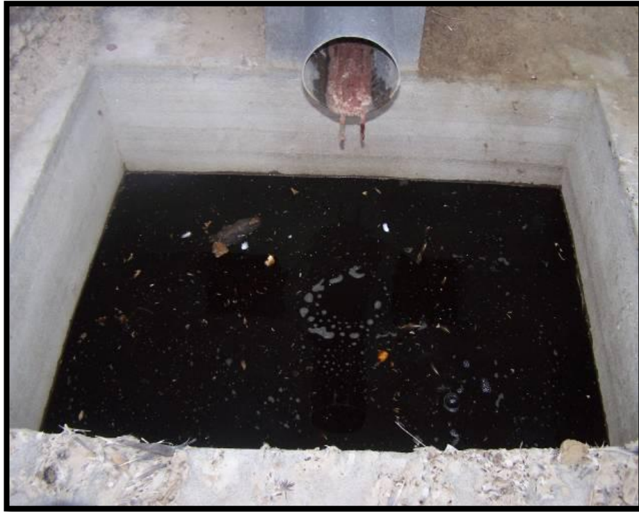
Imagen 57: Cámara ciega del saladero de cueros de material.
