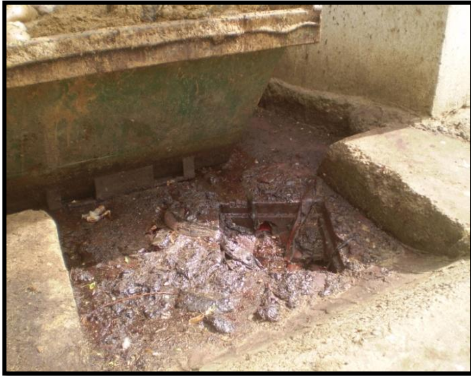
Imagen 26: Playón del contenedor de residuos industriales.
