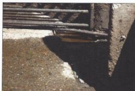
Foto N° 5. Abertura en la pared de la manga para bombeo de efluente.
