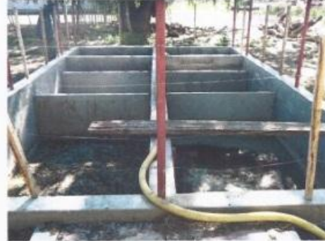
FOTO 10. Sedimentador.
