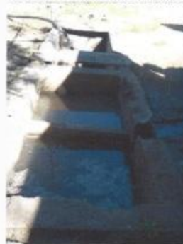
FOTO 2. Sedimentador del lavadero.
