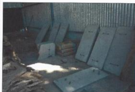
Foto N° 6. Nuevas tapas del sedimentador.
