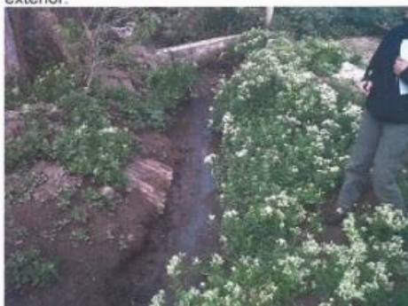
Foto 27. Conducción de efluente del lavadero al exterior.
