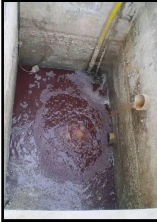
Imagen 10: Último compartimiento del sedimentador.
