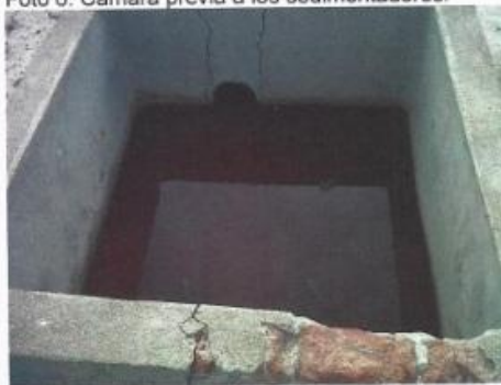
Foto 6. Cámara previa a los sedimentadores.
