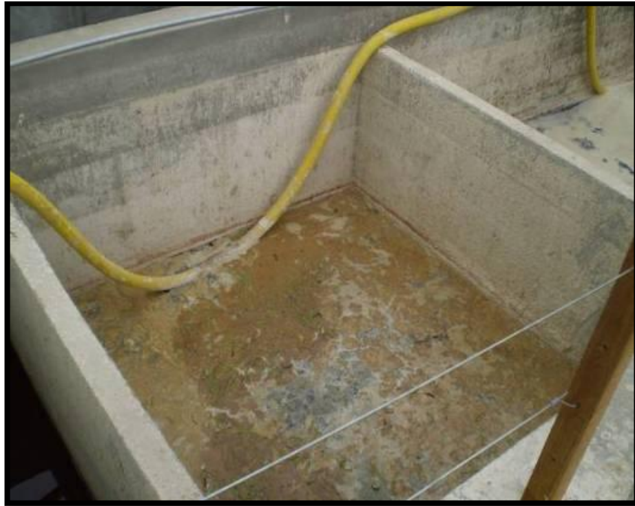
Imagen 9: Segundo compartimiento del sedimentador.
