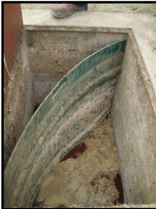
Imagen 5: Primer tamiz estático perforado.
