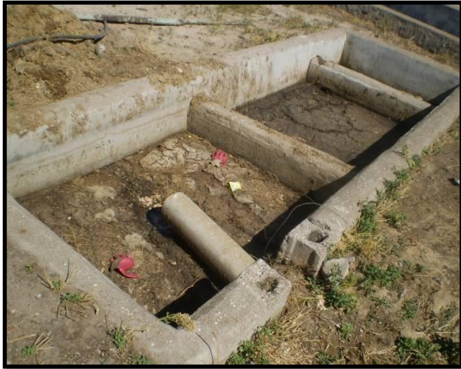
Imagen 43: Estercolero/sedimentador.
