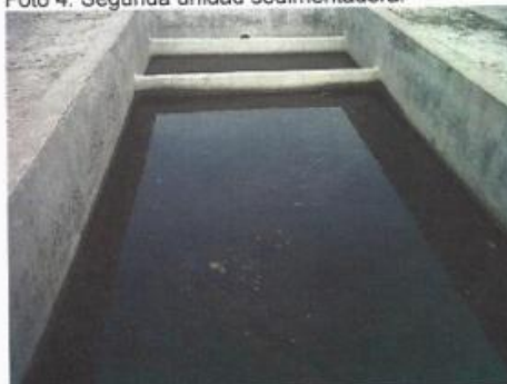
Foto 6. Cámara previa a los sedimentadores.
