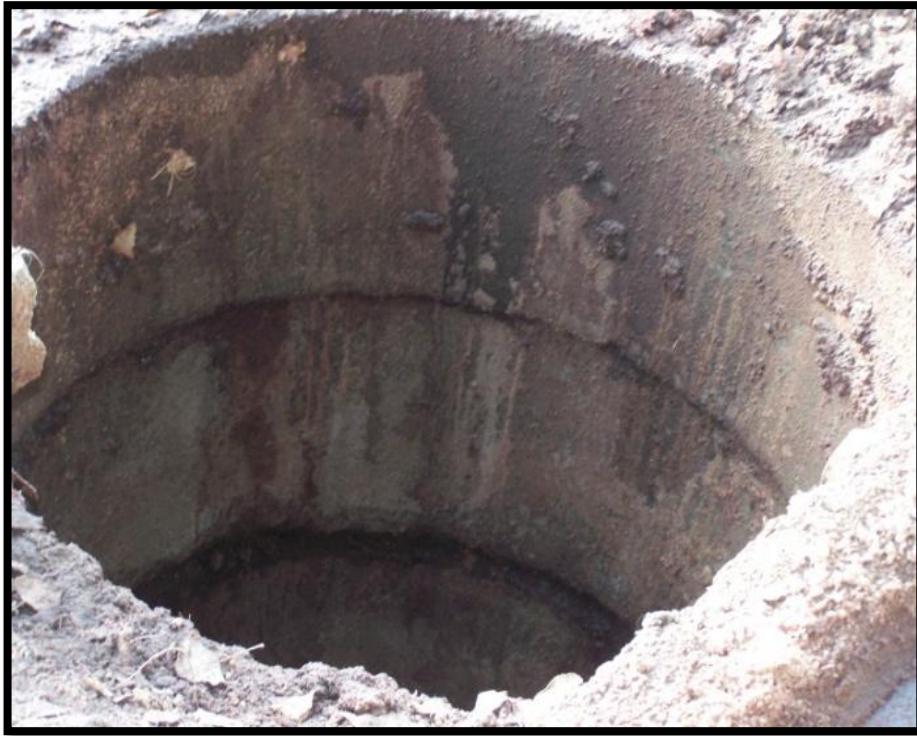
Imagen 36: Pozo del salado de cueros desagotado.
