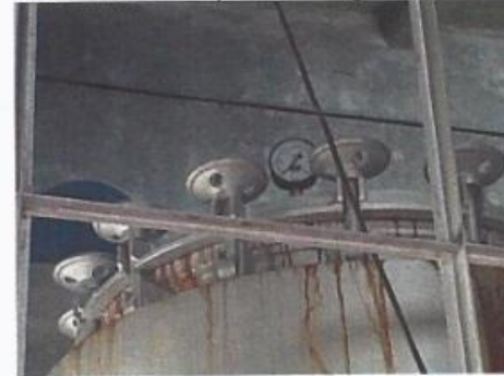
Foto 24. Medidor de presión del Digestor, en cero.
