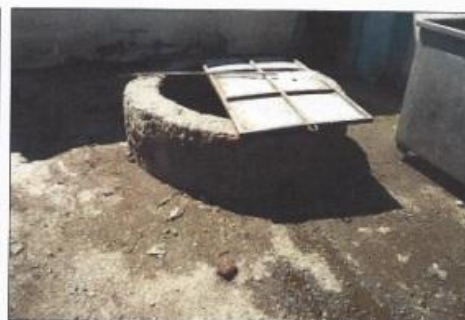
Foto N° 6. Nuevas tapas del sedimentador.
