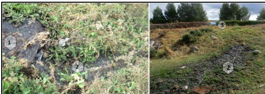
Figura 13: sistema cloacal de la escuela. (1) Tapa pozo absorbente. (2) Recorrido descendente del líquido séptico. (3) Salida de la escuela. Fuente: elaboración propia.
