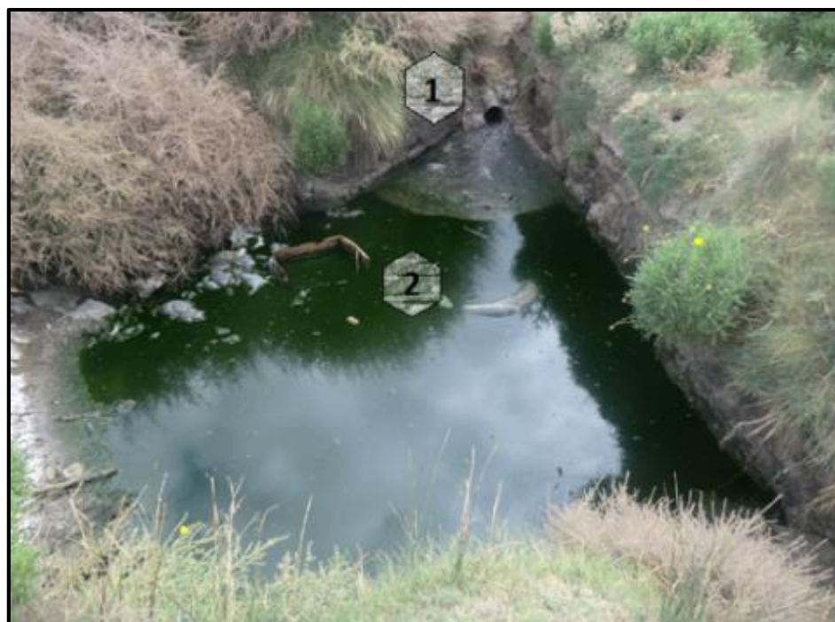
Figura 12: sistema cloacal de las viviendas. (1) Tubería de descarga. (2) Otro tipo de residuos. Fuente: propia.
