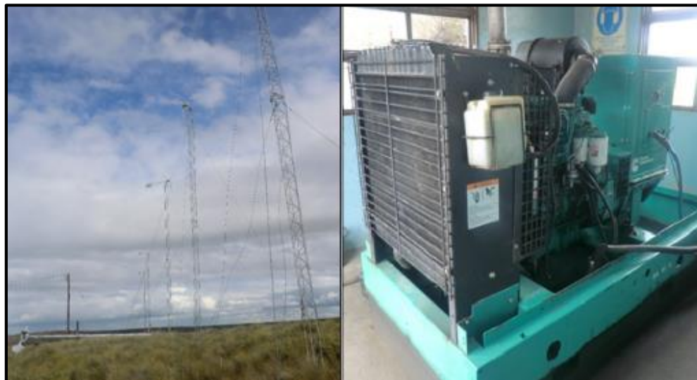
Figura 10: antiguo parque eólico con algunas estructuras aún en pie (izquierda). Grupo electrógeno (derecha). Fuente: propia.
