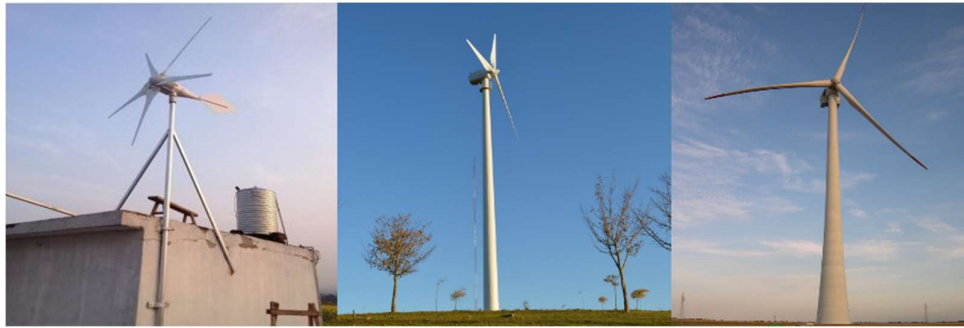
Figura 1.11: en la imagen de la izquierda, un aerogenerador pequeño de 1 kW instalado en una vivienda. En la del centro, un aerogenerador mediano de 100 kW. En la imagen de la derecha, un aerogenerador grande de 1 MW.
