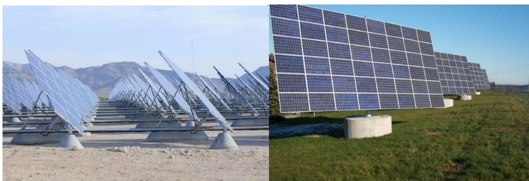
Figura 5.11: en la imagen de la izquierda, un seguidor solar de un eje. En la de la derecha, uno de doble eje.
