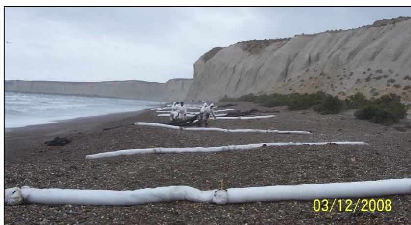
Figura 36: Disposición de booms de manera perpendicular a la línea de costa, en el primer día de atención a la contingencia.
