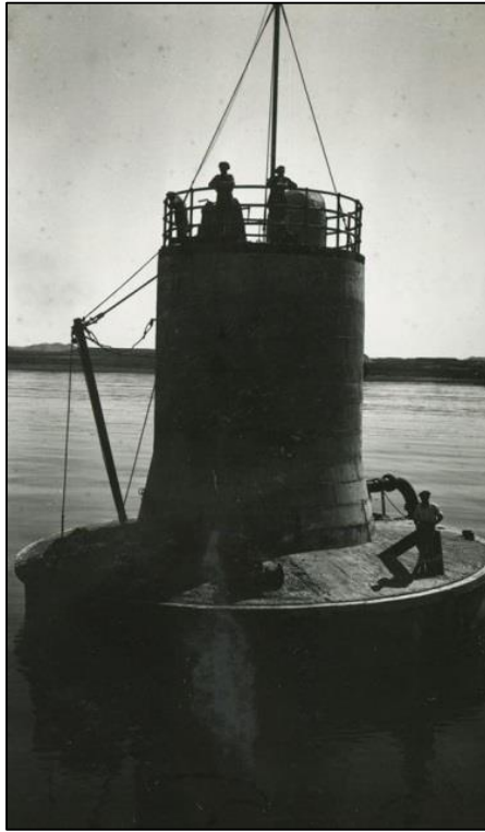
Foto 1: Pilar de amarre ubicado frente a las playas de Caleta Córdova para la carga de hidrocarburo a buques tanque. Fecha Década de 1920. Fuente: Archivo Histórico Municipal de Comodoro Rivadavia. Fondo Campamento – Astra.
