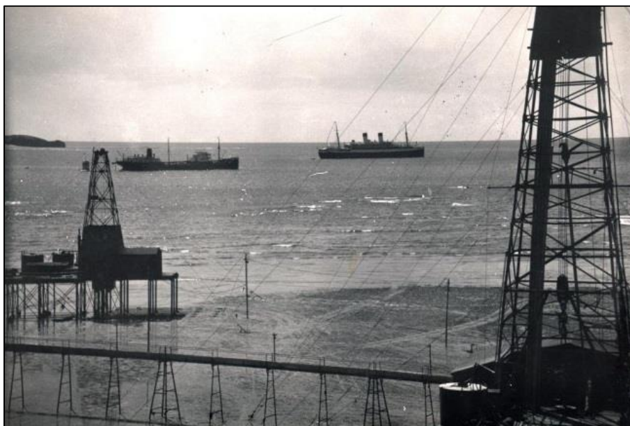
Foto 3: Vista desde Punta Pando hacia el antiguo pilar de amarre frente a las costas de Caleta Córdova. Torres de perforación y pasarelas sobre restinga. Fecha Década de 1920. Fuente: Archivo Histórico Municipal de Comodoro Rivadavia. Fondo Campamento – Astra.
