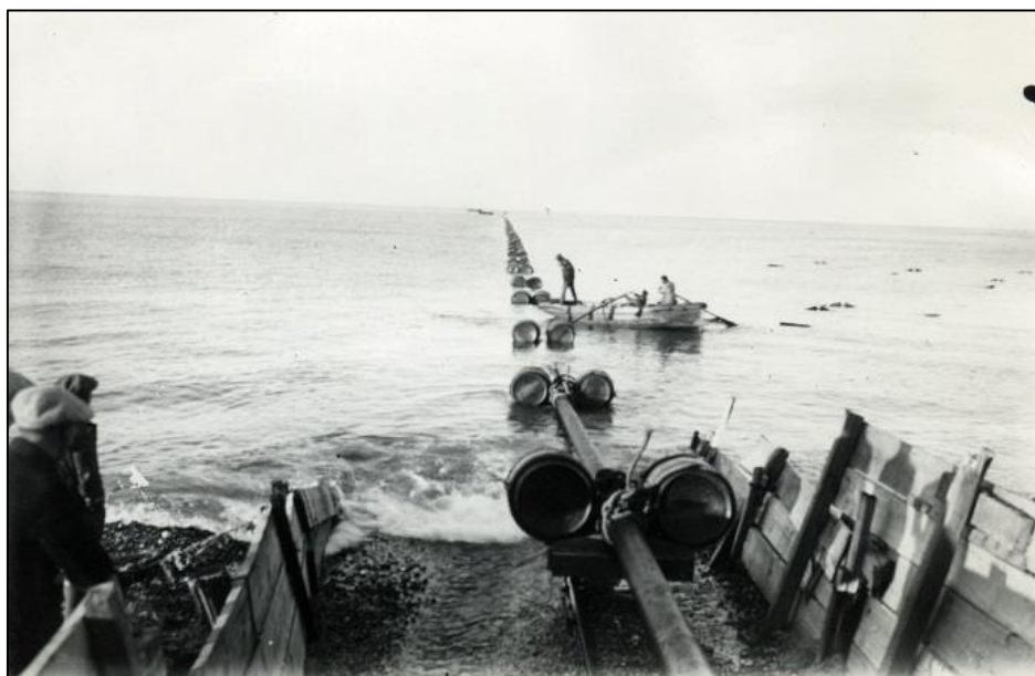
Foto 4: Instalación de ductos submarinos para el futuro transporte de petróleo desde el ambiente terrestre hacia el pilar, en el ambiente marino. Fecha Década de 1920. Fuente: Archivo Histórico Municipal de Comodoro Rivadavia. Fondo Campamento – Astra.
